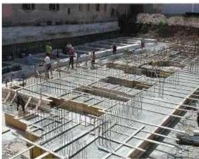
Le fondazioni, la struttura portante in c.a., i pilastri del “telaio” ed i solai saranno eseguiti conformemente agli elaborati progettuali strutturali, al progetto architettonico ed ai calcoli statici depositati, ai sensi delle vigenti leggi in materia, presso le competenti autorità. In particolare le strutture in conglomerato cementizio armato saranno calcolate nel rispetto della Legge vigente.
