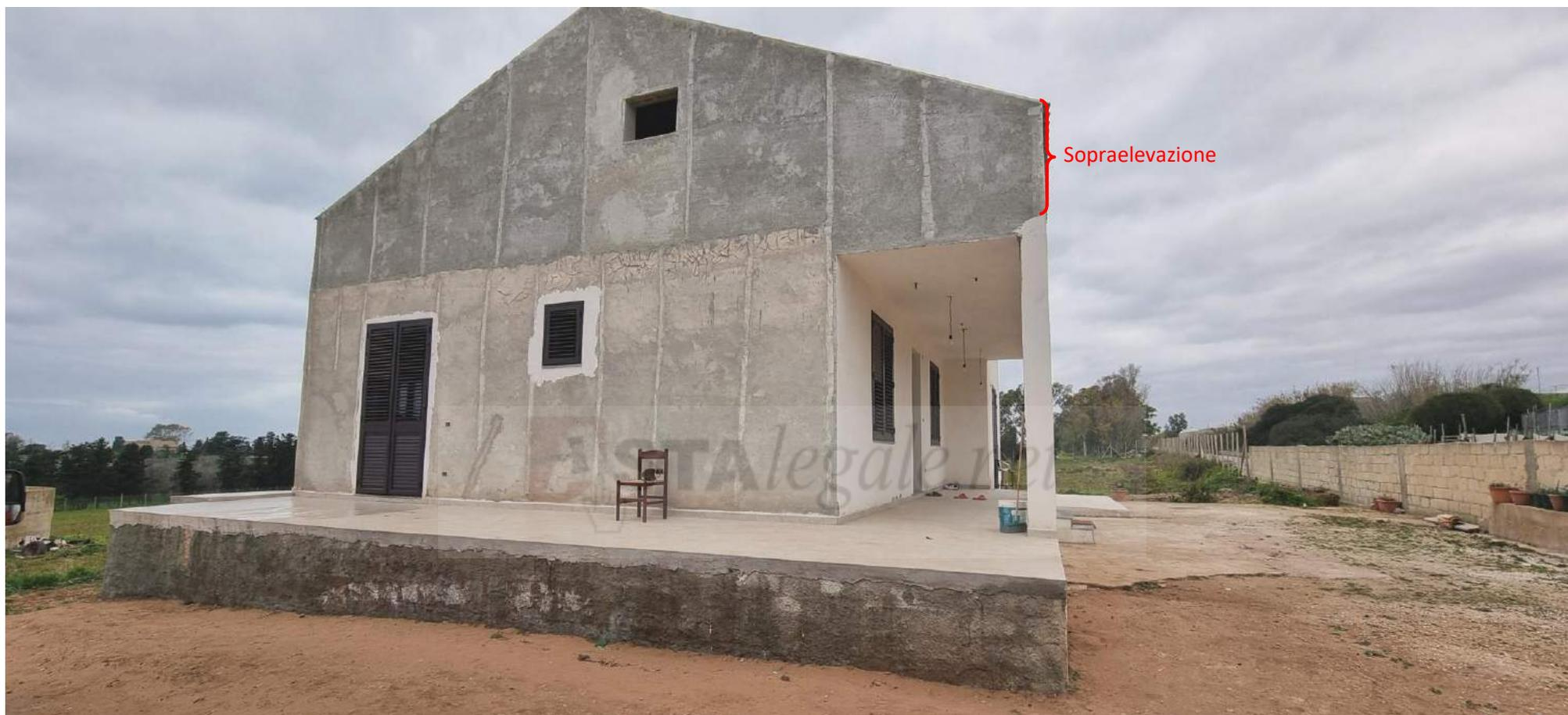
Foto n. 21 - Secondo fabbricato (particella 474, sub 1, A/3 di 1<sup>a</sup> classe) - Prospetto sud. Si noti la sopraelevazione e la copertura a tetto entrambe abusive.
