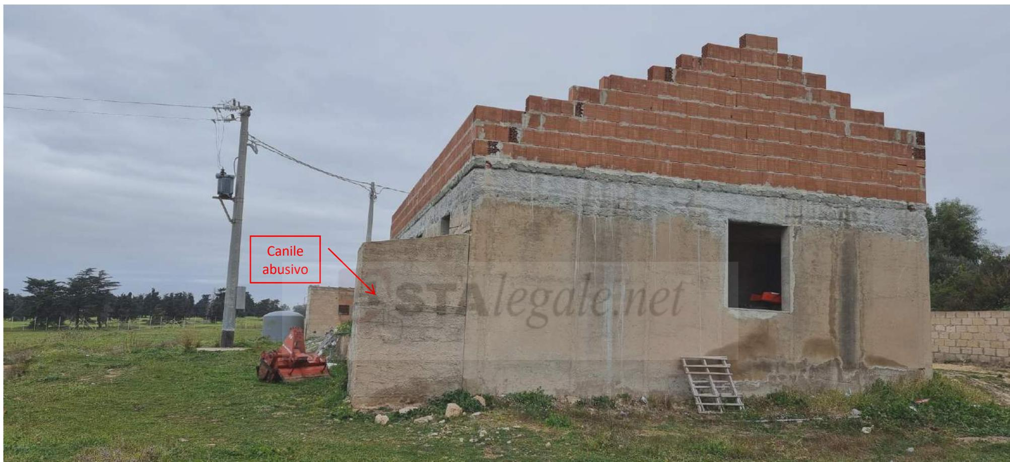
Foto n. 18 - Primo fabbricato (particella 404, sub 2, D/10) - Prospetto laterale (a sud) - Si notino la sovrelevazione e il casottino-canile, entrambi abusivi.
