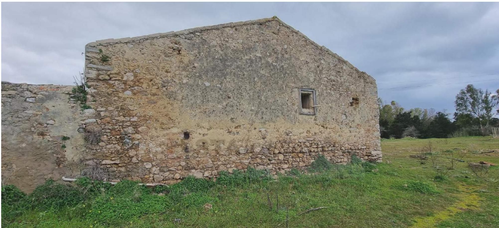
Foto n. 43 - Quinto fabbricato (particella 664, sub 2, A/4 di 2<sup>a</sup> classe) - Prospetto laterale a nord profondamente deteriorato specialmente nella parte basale dei muri.
