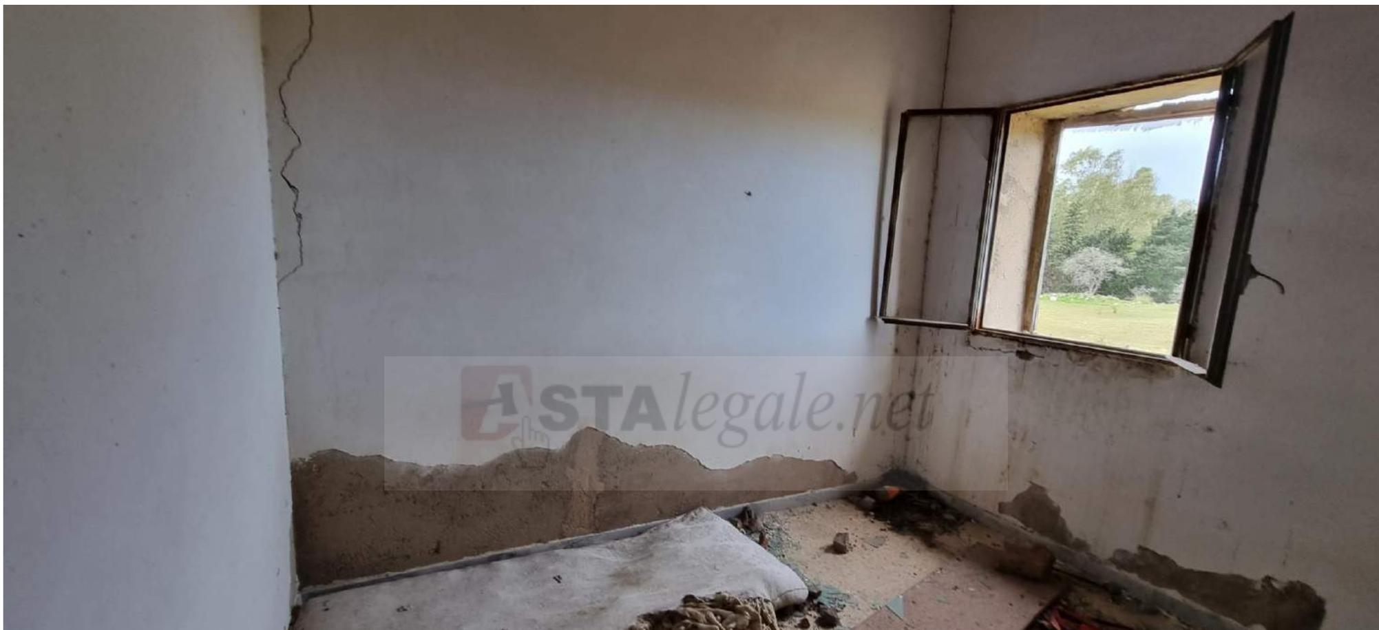
Foto n. 41 - Quinto fabbricato (particella 664 sub 2, A/4 di 2ª classe). Camera con intonaci scrostati e lesionati, infissi interni divelti (a terra) ed esterni inservibili.
