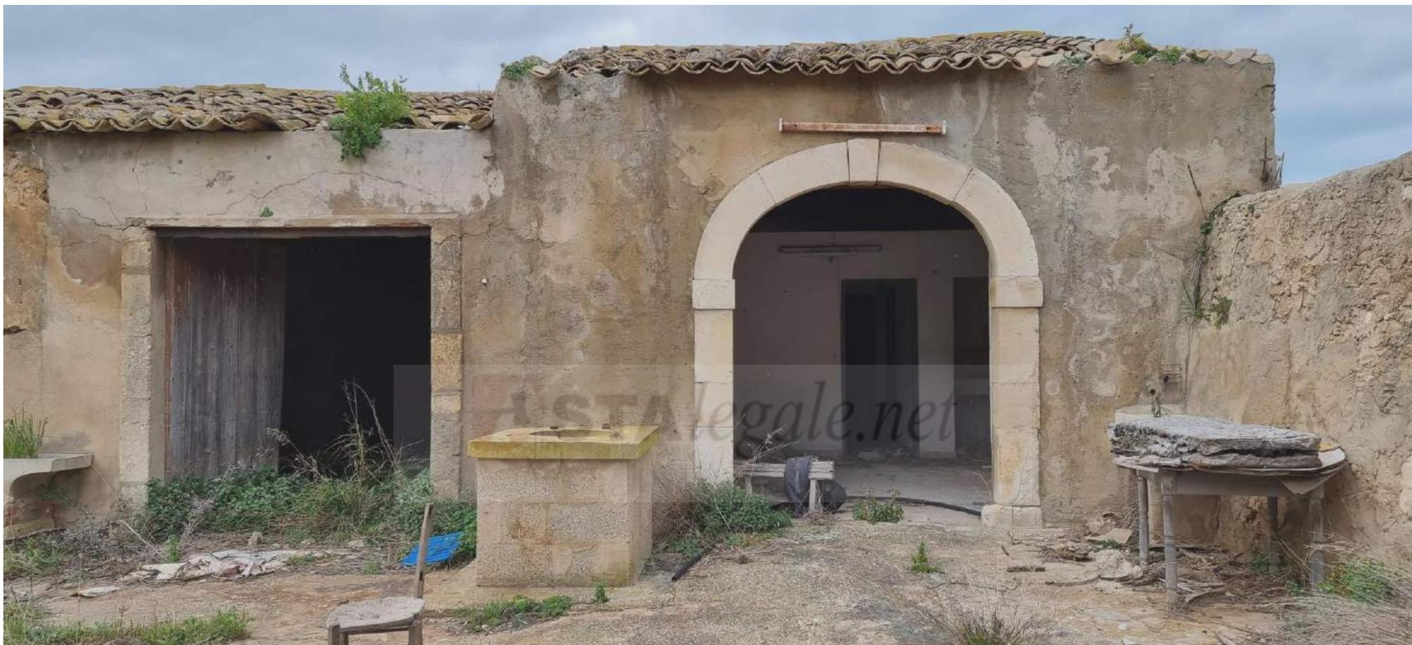
Foto n. 39 - Quinto fabbricato (particella 664, sub 1, D/10, e sub 2, A/4 di 2<sup>a</sup> classe) -Prospetto principale. Si notino le precarie condizioni statiche e conservative.
