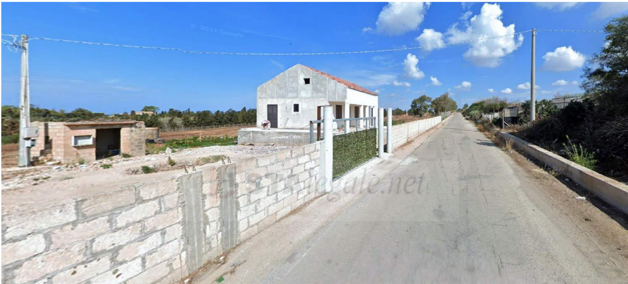
Foto n. 1 – Il cancello di accesso alla proprietà pignorata (primo corpo)
