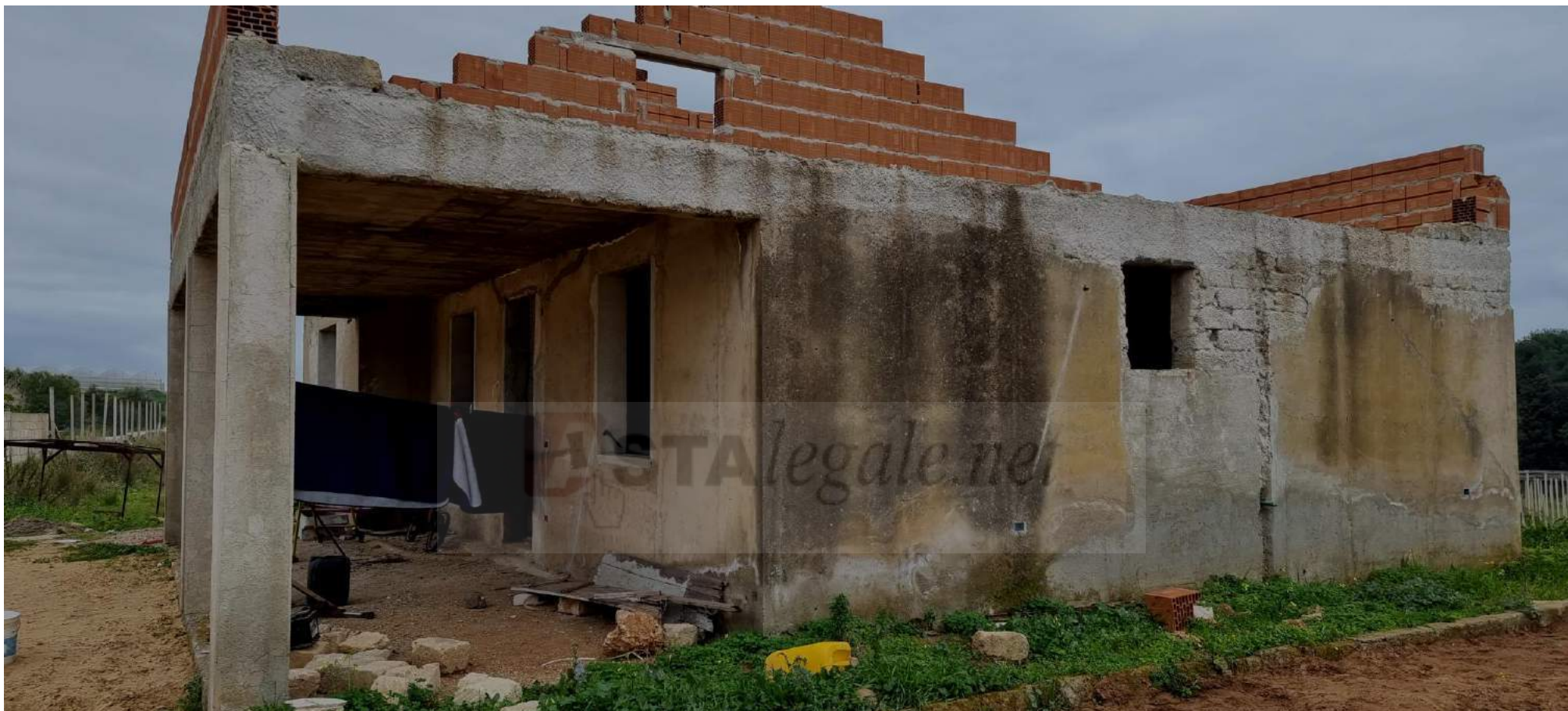
Foto n. 12 - Primo fabbricato (particella 404, sub 1, A/3 di 1ª classe) - Prospetto laterale (a nord). Si noti l'avvio della sopraelevazione.
