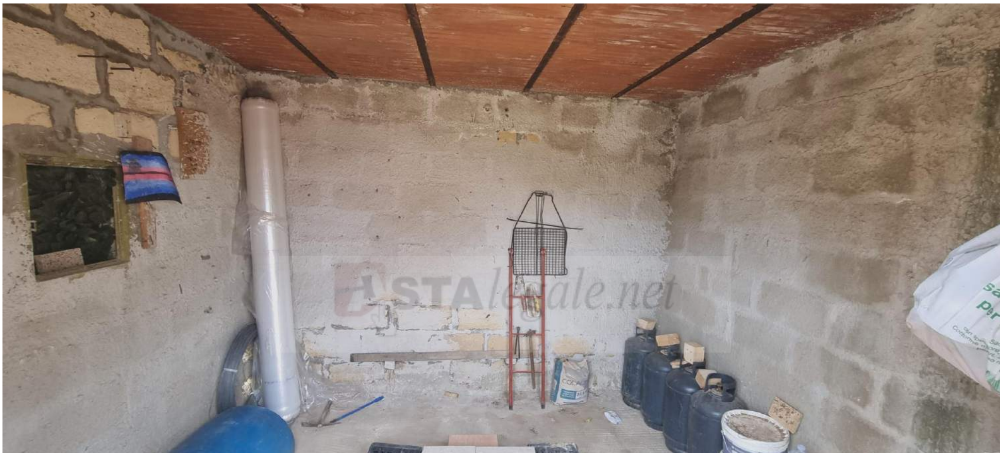
Foto n. 35 - Terzo fabbricato (particella 663, sub 1, D/10) - Interno allo stato rustico.
