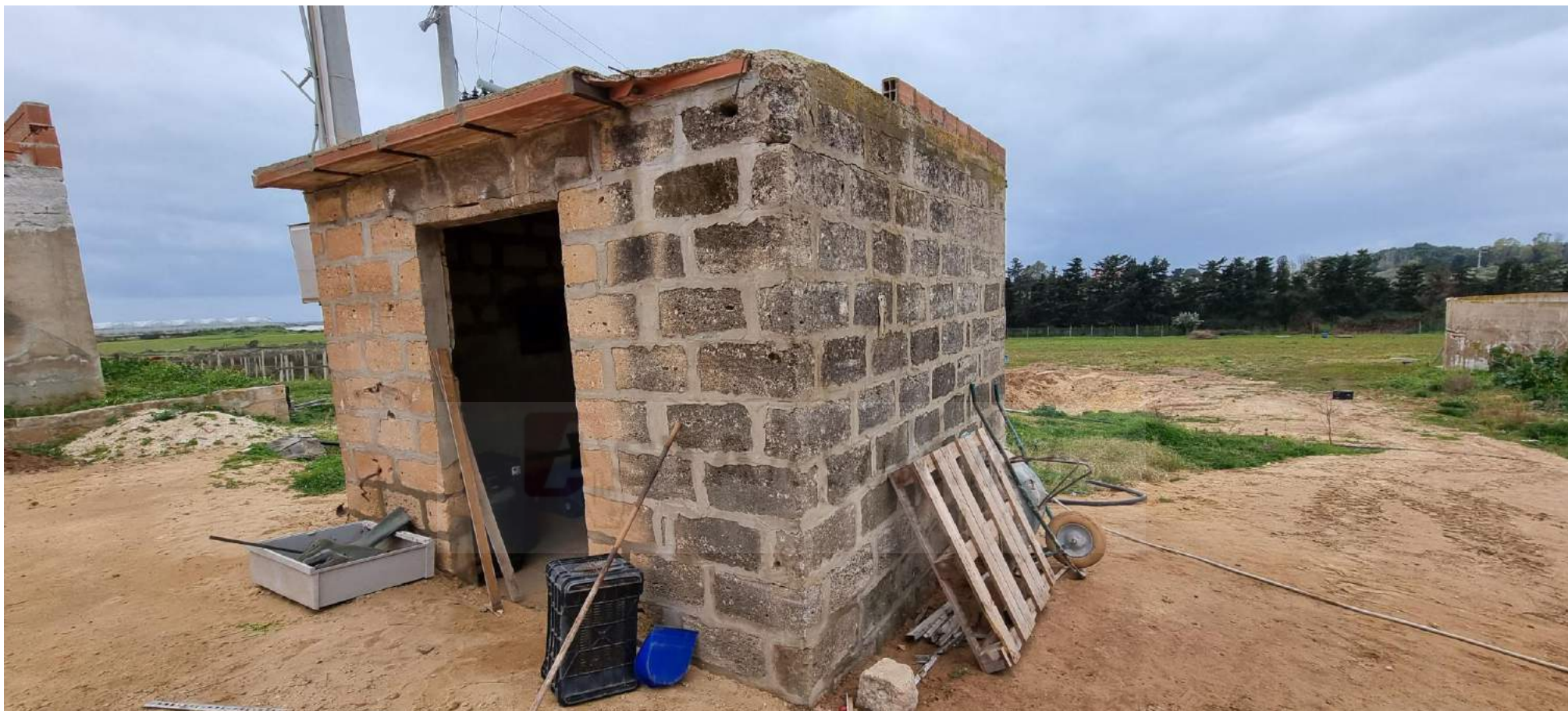
Foto n. 33 - Terzo fabbricato (particella 663, sub 1, D/10) - Prospetto principale ad est e prospetto laterale a nord.
