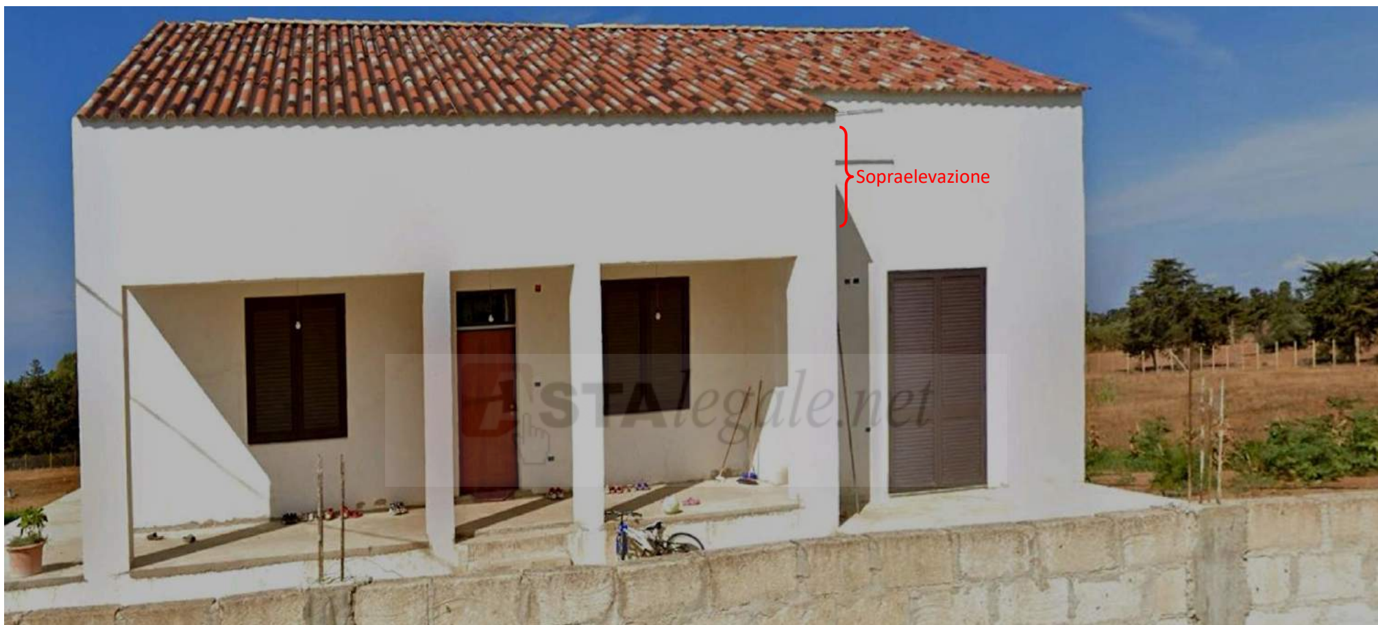
Foto n. 20 - Secondo fabbricato (particella 474, sub 1, A/3 di 1ª classe) - Prospetto principale (ad est). Si noti sopraelevazione e la copertura a tetto entrambe abusive.
