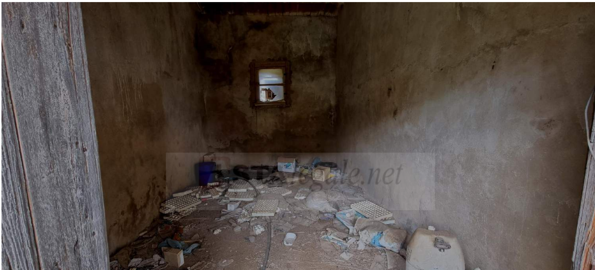
Foto n. 38 - Quinto fabbricato (particella 664, sub 1, D/10) - Vano rurale abbandonato.
