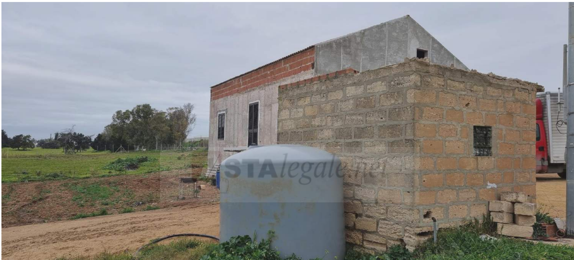
Foto n. 34 - Terzo fabbricato (particella 663, sub 1, D/10) - Retro prospetto e prospetto laterale a sud.
