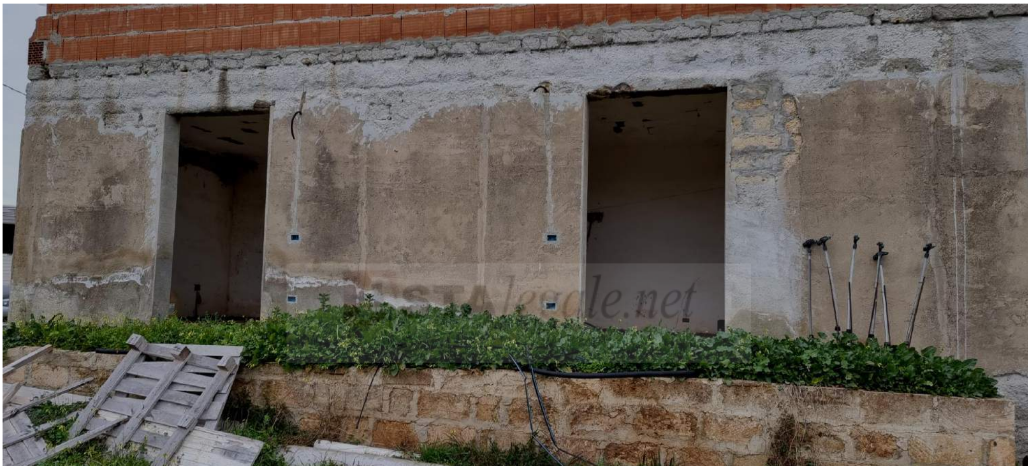
Foto n. 13 - Primo fabbricato (particella 404, sub 1, A/3 di 1ª classe) - Retro prospetto (ad ovest). Si noti la banchina esterna inerbita e la sopraelevazione abusiva.
