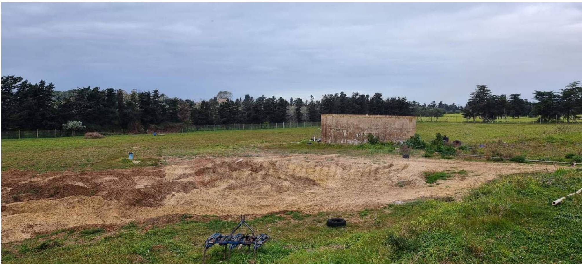
Foto n. 6 - Lo scavo di cui alla precedente foto
