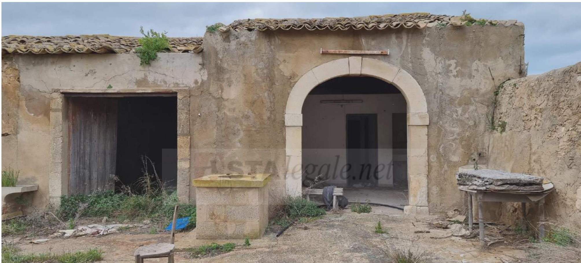
Foto n. 39 - Quinto fabbricato (particella 664, sub 1, D/10, e sub 2, A/4 di 2 a classe) -Prospetto principale. Si notino le precarie condizioni statiche e conservative. N.B.: La cisterna di cui si intravede il collo ricade sulla corte comune e, quindi, non rientra fra le proprietà staggite.
