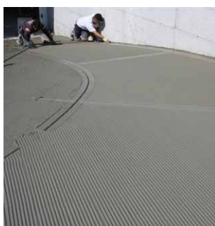
D1 - d _ Rampa corsello
