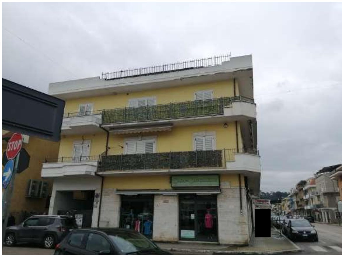
- Vista esterna del fabbricato su Via E.Toti
