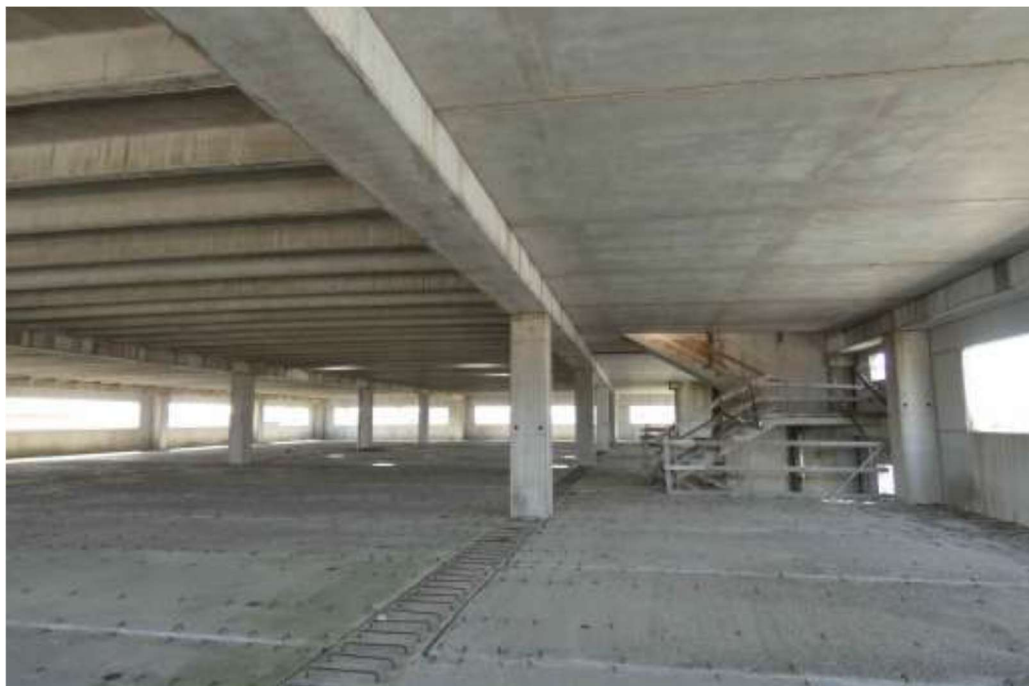
Foto 7 il primo piano, l'altezza risulta inferiore rispetto al piano terra
