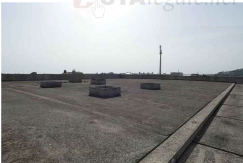
Foto 8 il lastrico solare in cui sono visibili i cinque lucernai
