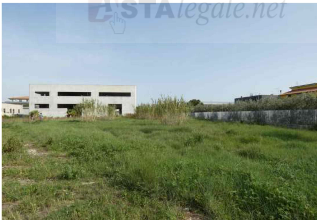
Foto 2 la foto scattata dall'ingresso di via Valtellina inquadra il retro del manufatto anche se l'accesso è stato possibile attraverso particelle intestate a ditte non oggetto di esecuzione. Preciso che alla data del sopralluogo non era presente alcuna recinzione tra dette particelle e il bene eseguito
