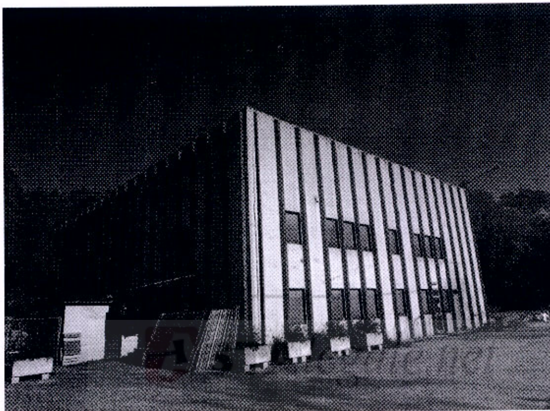
Foto Capannone con box pesa lato Sud/Ovest
