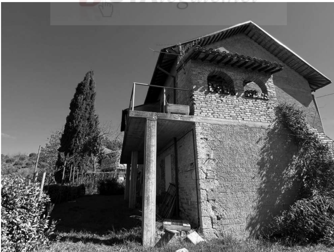
ESTERNO LATO SUD
