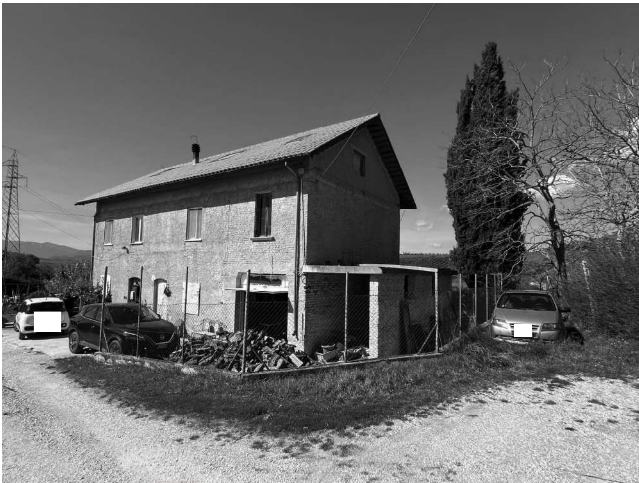
ESTERNO LATO EST
