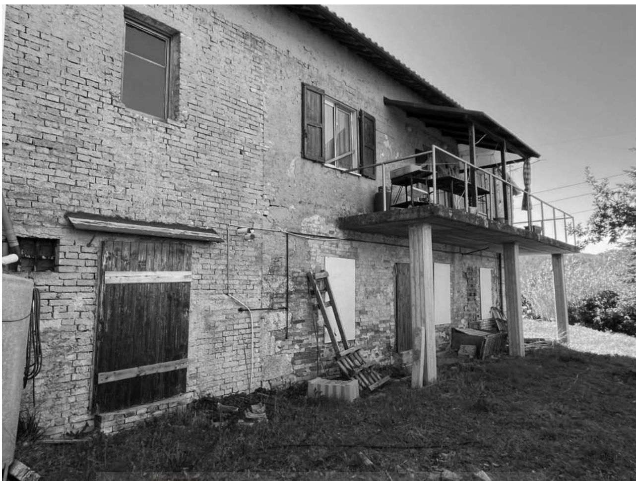
ESTERNO LATO OVEST
