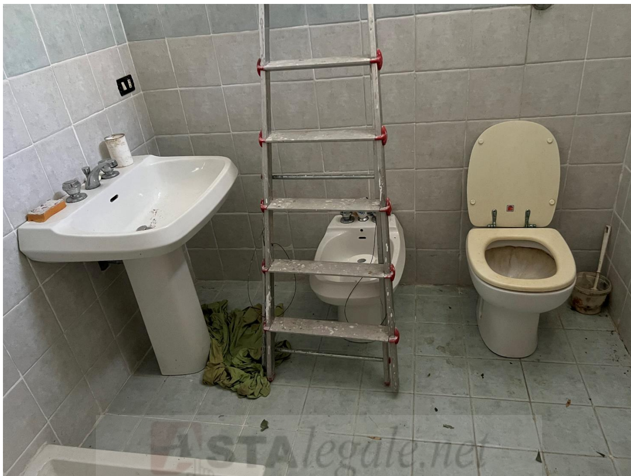
BAGNO NEL GARAGE
