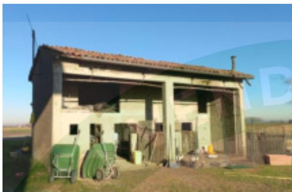
N. 5 - Il piccolo manufatto adibito a pollaio è attualmente in uso. E' un manufatto con forma rettangolare compatta. La struttura è realizzata in muratura portante con mattoni pieni. Una porzione longitudinale è dotata di un solaio che ospita un deposito.
