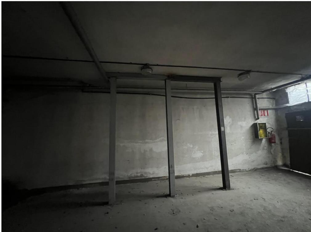
*Foto 10. - Struttura di rinforzo del solaio*
