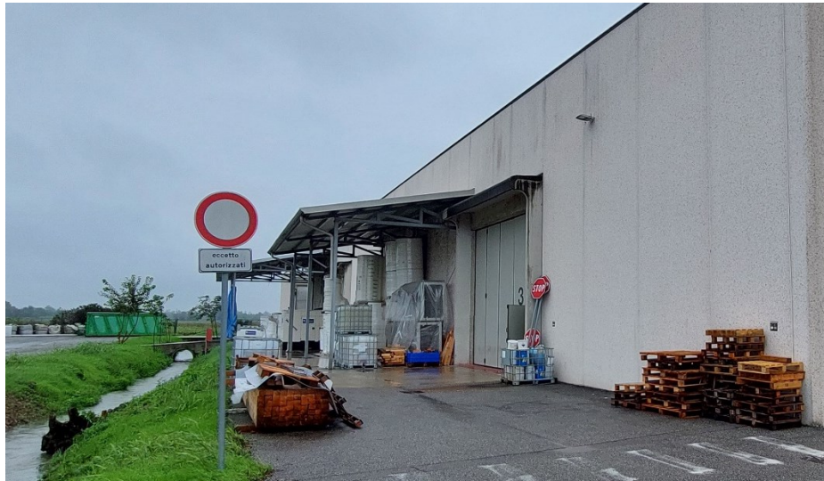
Tettoie da rimuovere
