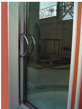
Il portoncino a piano terra di accesso alle unità immobiliari di piano primo sarà realizzato in profili di alluminio o PVC e vetrocamera isolante, dotato di maniglia ed elettroserratura.
