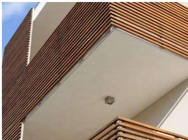
Le porzioni di facciata indicate in progetto NON intonacate, verranno finite con rivestimenti lignei o simil-legno, fissati su apposite strutture metalliche.
