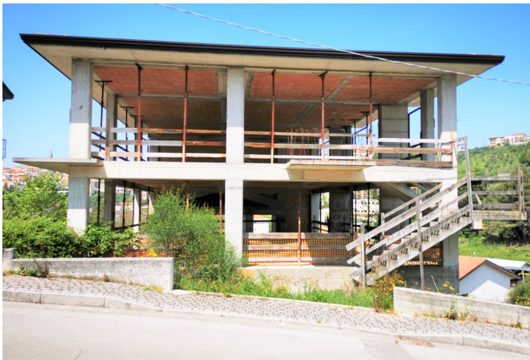
Foto 1 - Il corpo di fabbrica più alto visto da via Pietro Nenni, lato monte, con due piani fuoriterra.
