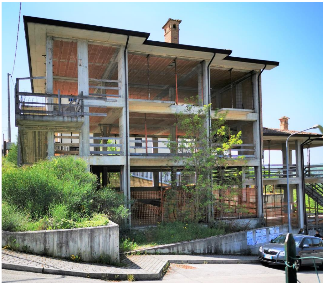
Foto 3 - Il corpo di fabbrica più alto visto da via Pietro Nenni, nel tratto in discesa, con i tre piani, per tre lati completamente fuori terra.
