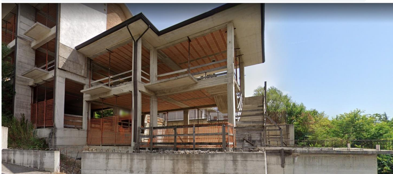
Foto 4 - Il corpo di fabbrica con due piani fuori terra
