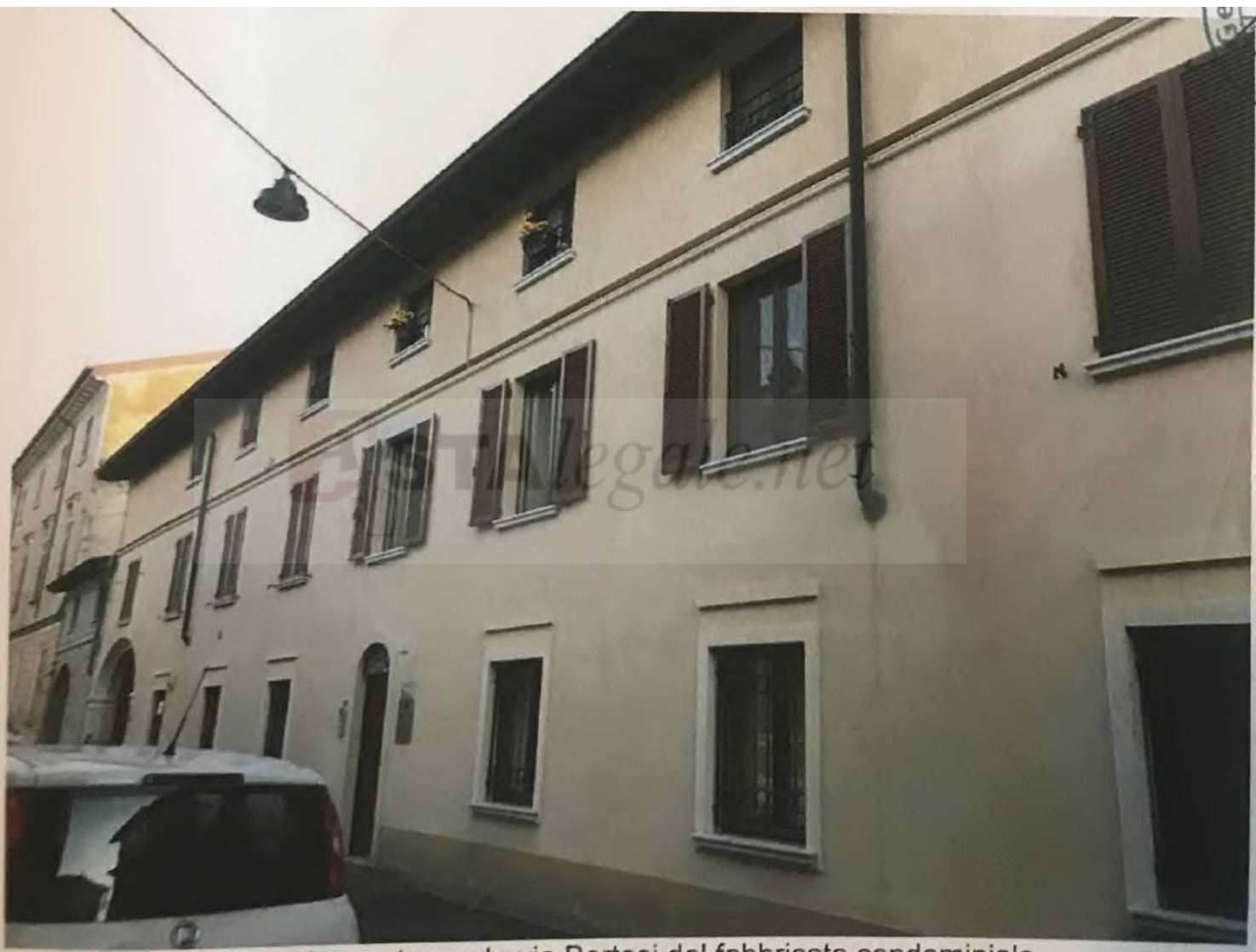
...ione da via Portici del fabbricato condominiale
