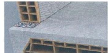
**4.4 Tramezzature interne** a garage e servizi al piano interrato, sono realizzati con blocchi in laterizio intonacati al civile REI 30 da cm.15 e verniciati.
