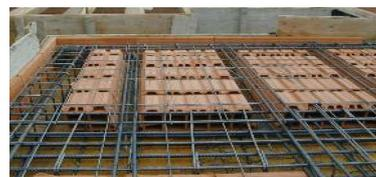
**3.3 Solaio di copertura delle autorimesse** e dei servizi dell'interrato sono realizzati in lastre tralicciate prefabbricate tipo predalles, come da calcoli strutturali, con adeguato copriferro e certificazione antincendio, lasciate a vista.
