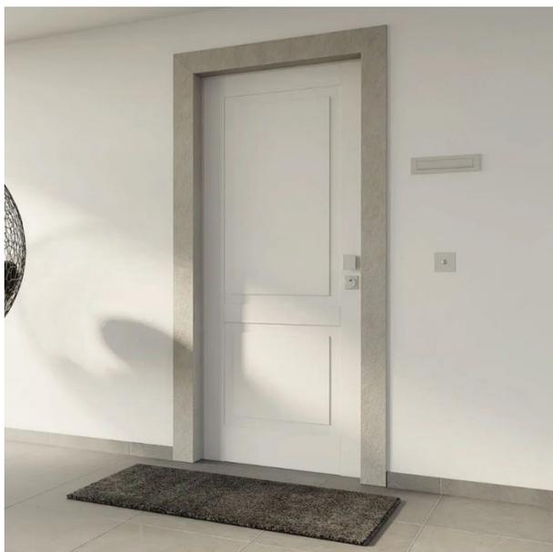
Le porte saranno posate su telai in acciaio con falso telaio murato; anta con telaio angolare laccato, finitura interna RAL 9010, e finitura del pannello esterno a scelta della D.L.; spioncino interno e maniglia finitura cromo lucido, modello doppia pera (interno/esterno).
