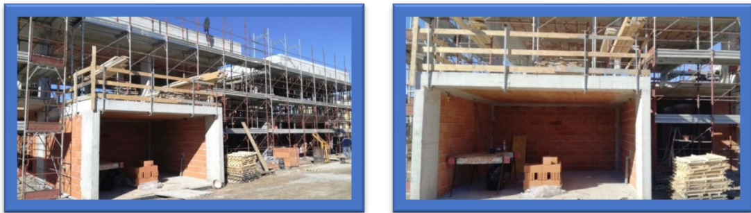
Un'autorimessa della Residenza "California" in fase di costruzione
