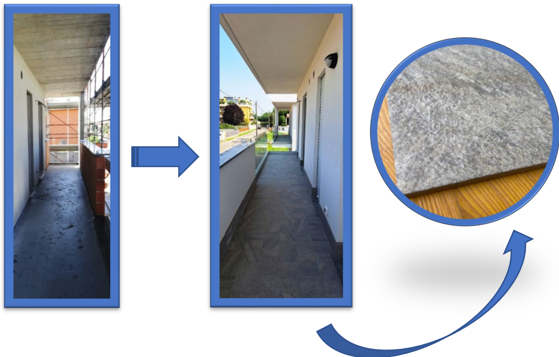
Fasi di realizzazione dei balconi e dettaglio del pavimento
