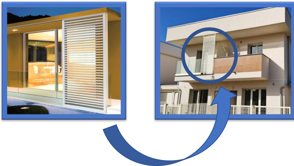
Dettaglio del modello di pannello frangisole utilizzato sui balconi del Lotto B
