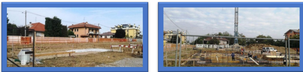
Fasi preliminari all'edificazione delle Unità del Lotto A della Residenza "California"
