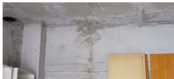
Il garage sub. 17 (Lotto 5): si nota il degrado delle travi in cemento armato della copertura dell'area esterna, nonché della parte interna, a causa delle infiltrazioni dal tetto
