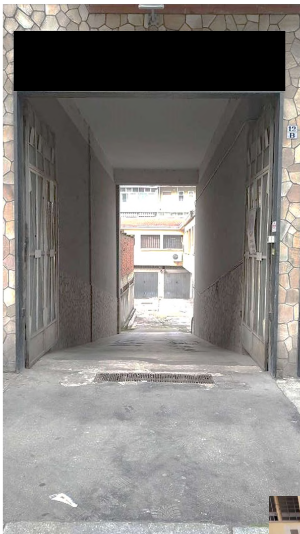
Il passo carraio al civico 12/B di Via Monastir e la rampa di accesso al piano cortile ribassato
