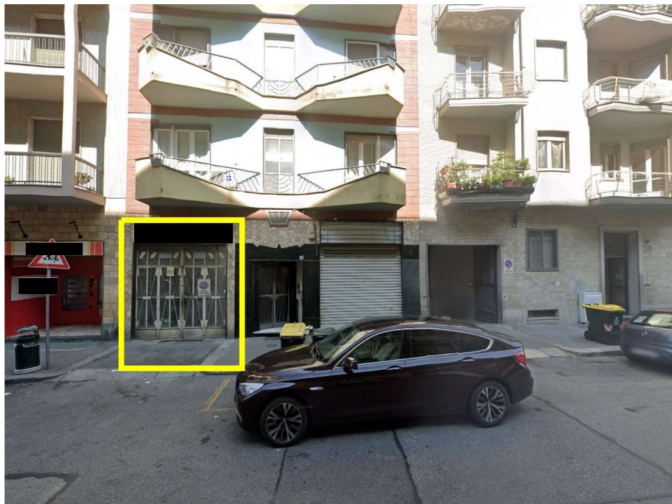
Il portone di ingresso alle autorimesse ubicato al civico 12/B di Via Monastir
