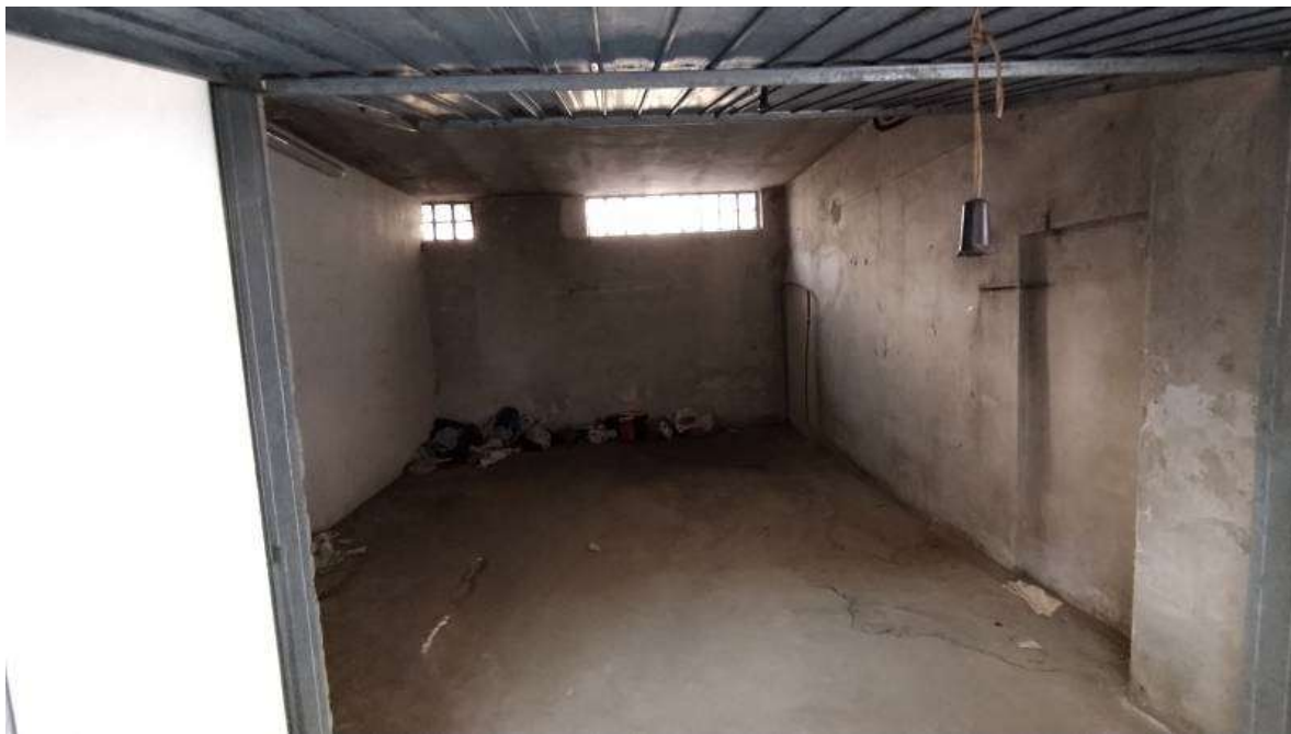
Interno del garage subalterno 19 (Lotto 7)
