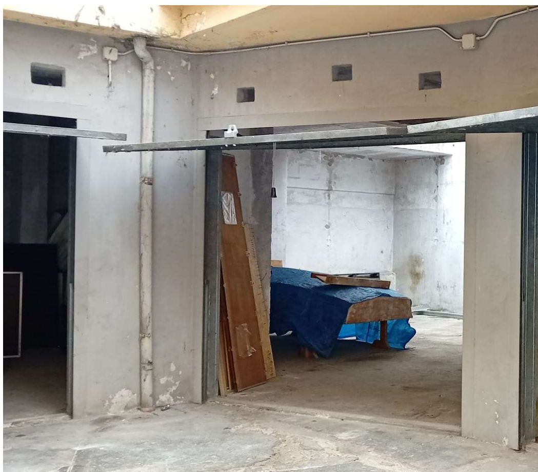
Interno del garage subalterno 18 (Lotto 6)
