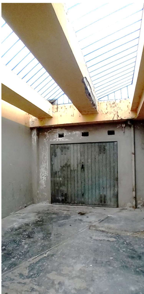
Il garage sub. 17 (Lotto 5): si nota il degrado delle travi in cemento armato della copertura dell'area esterna, nonché della parte interna, a causa delle infiltrazioni dal tetto
