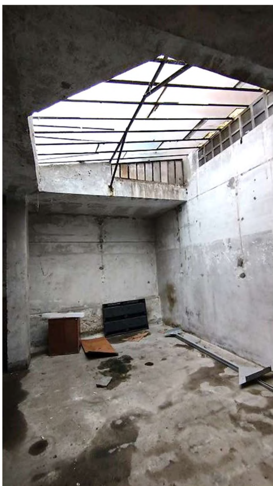
Altre immagini del garage sub. 18 (Lotto 6): si notano vaste aree ammalorate a causa di infiltrazioni di acqua dal tetto oltre al deterioramento della copertura in vetro
