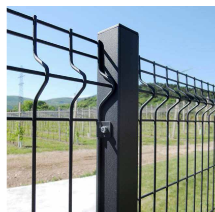
E_ Dettaglio recinzione perimetrale
