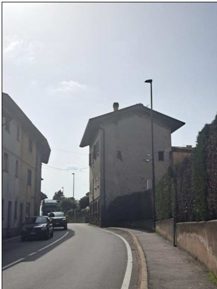
Vista fabbricato da via Roma
