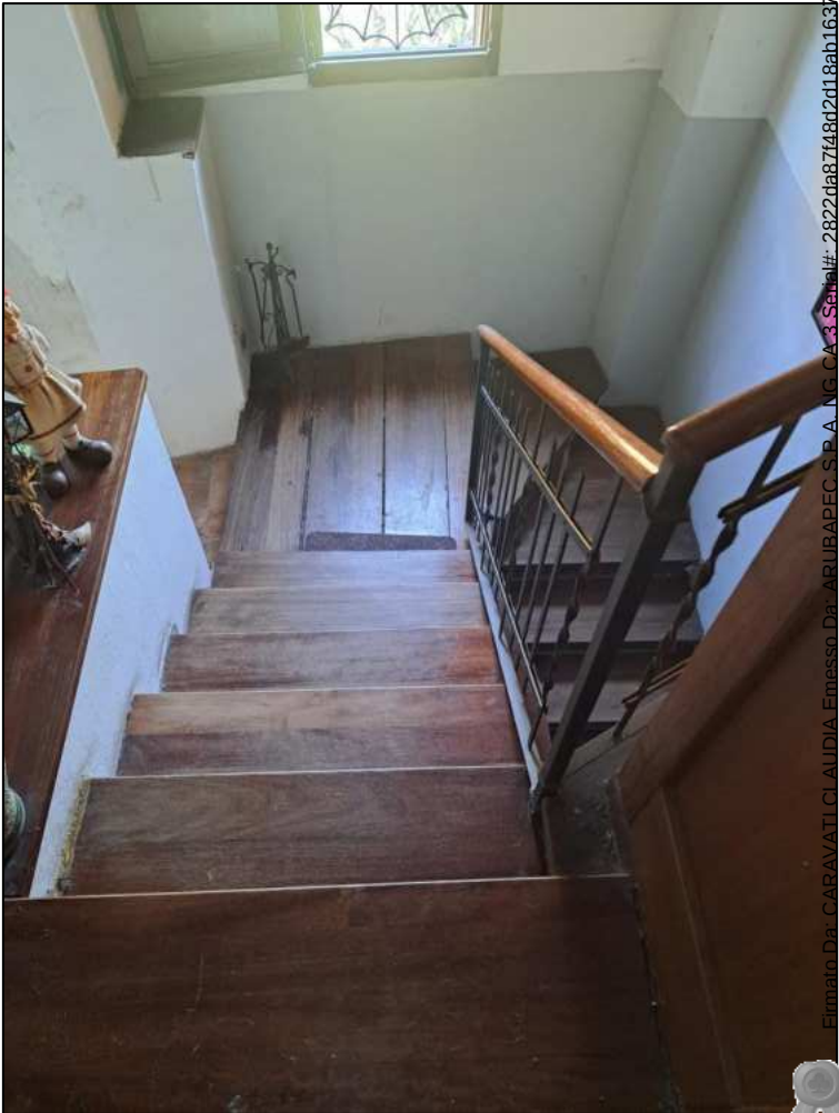
Vano scala comune
