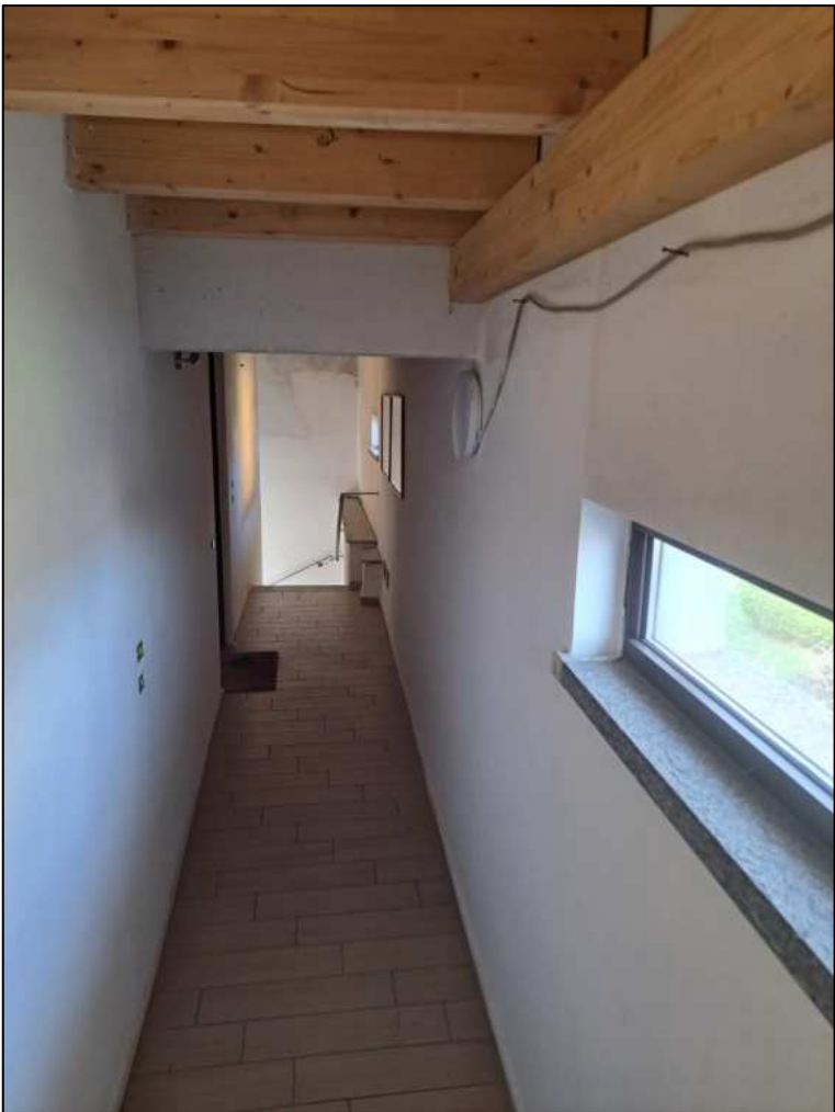
Vano scala comune
