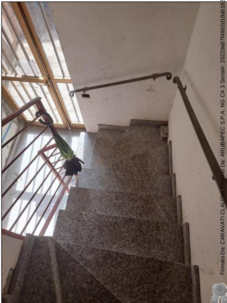
Vano scala comune
