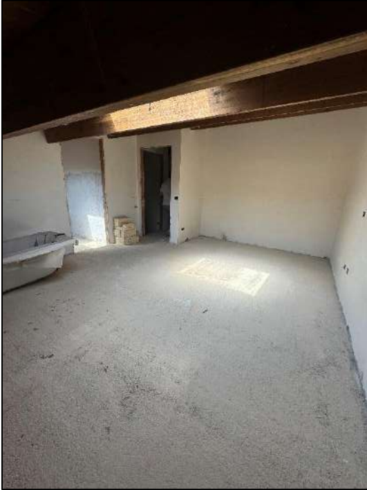
Foto interna dei locali
