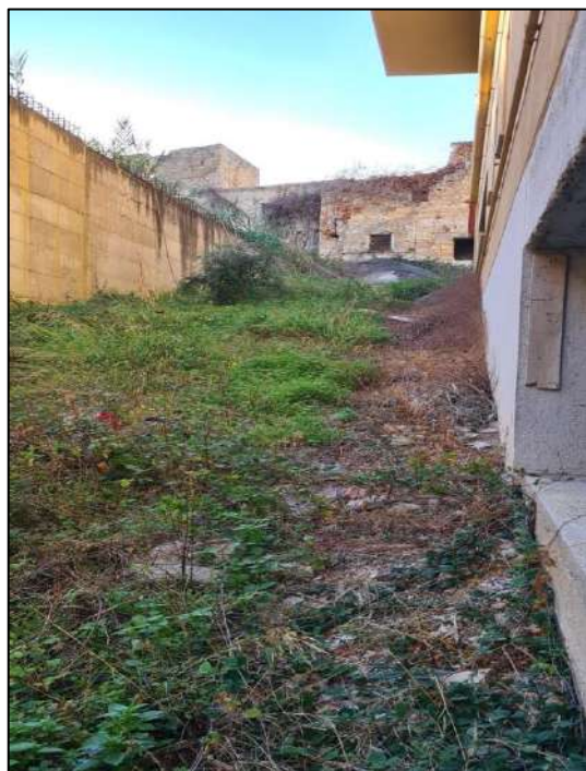
Rampa di accesso al piano cantinato
