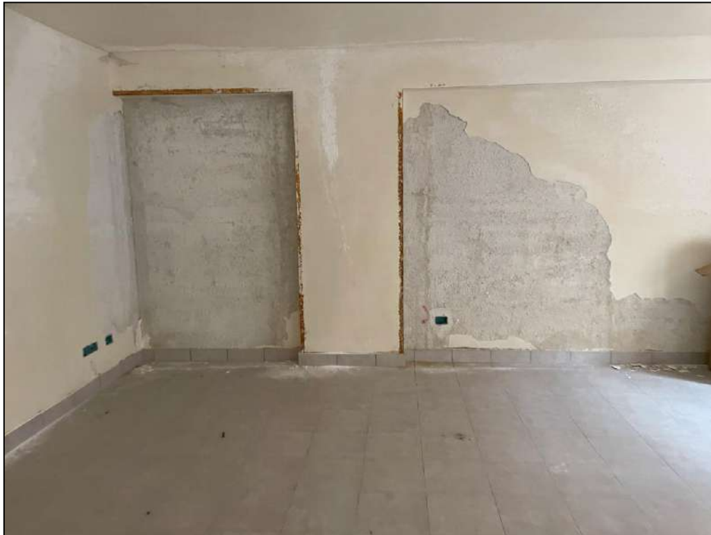
Foto interna dei locali
