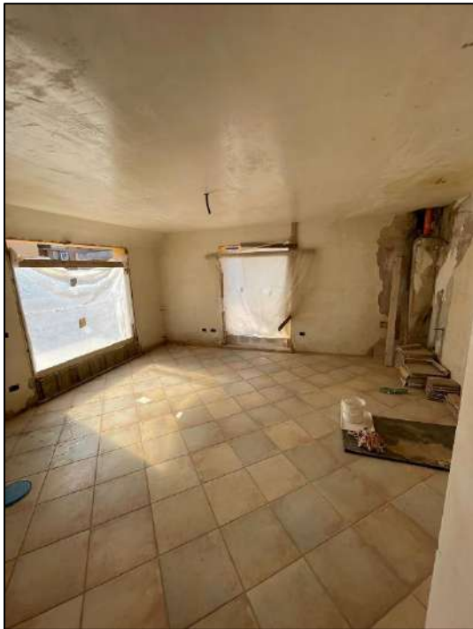
Foto interna dei locali
