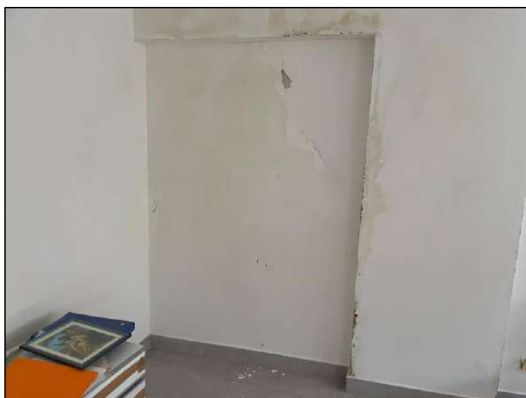
Foto interna dei locali
