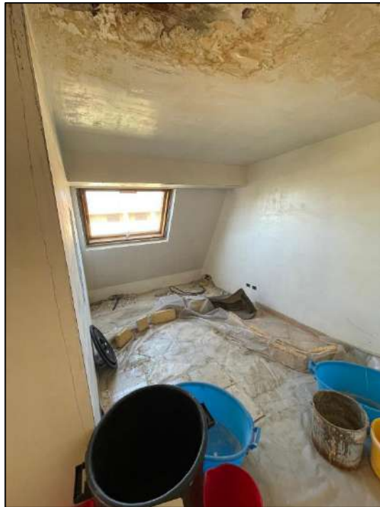
Foto interna dei locali
