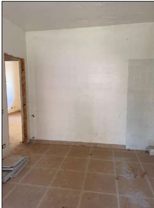
Foto interna dei locali
