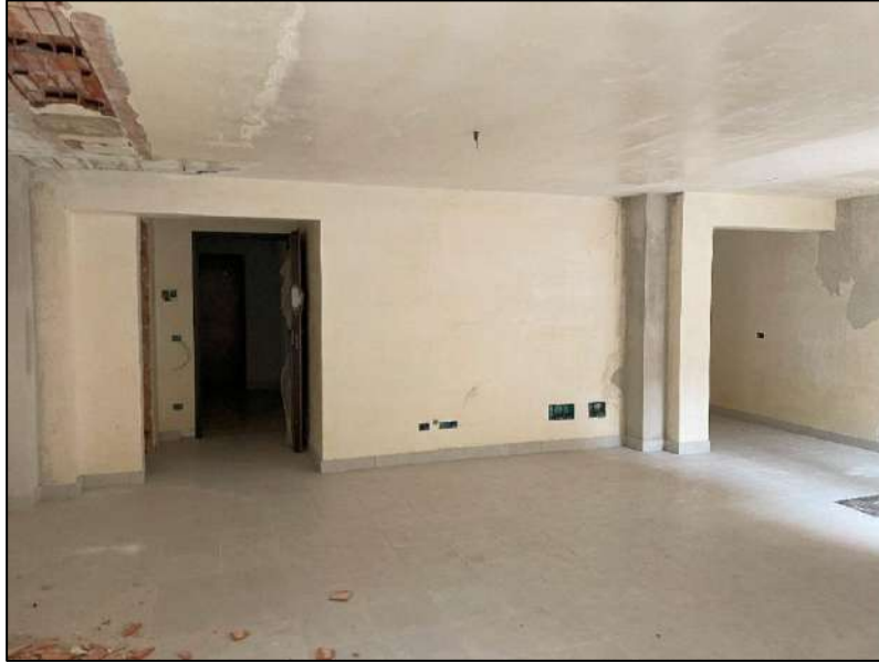
Foto interna dei locali
