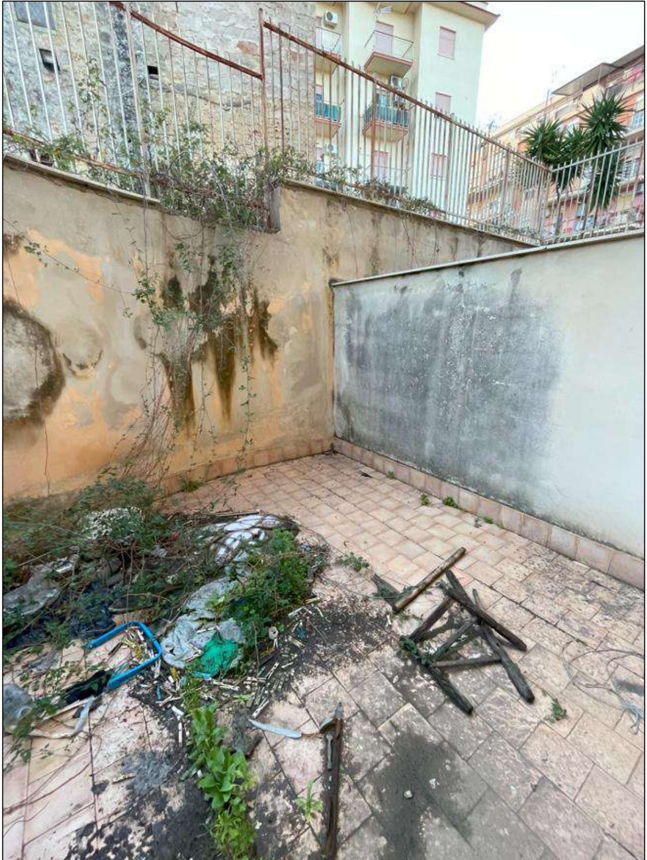
Foto esterna particolare corte esclusiva
