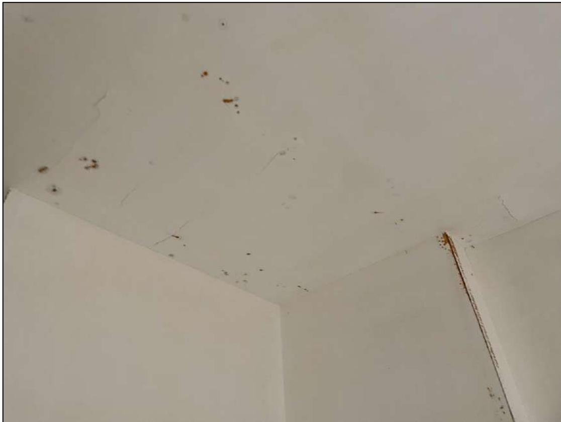
Foto interna dei locali
