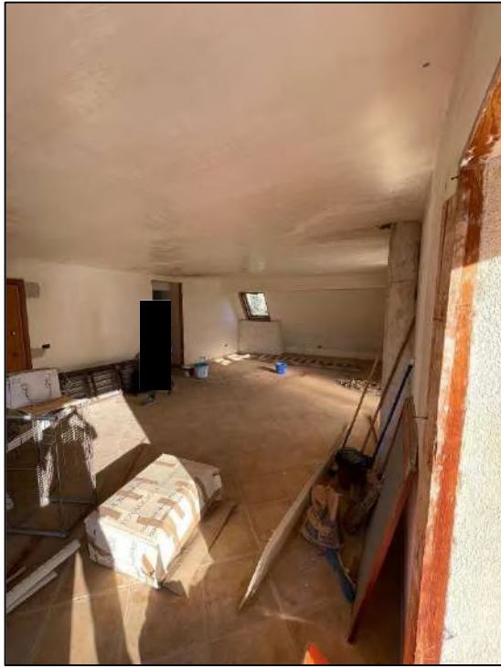
Foto interna dei locali
