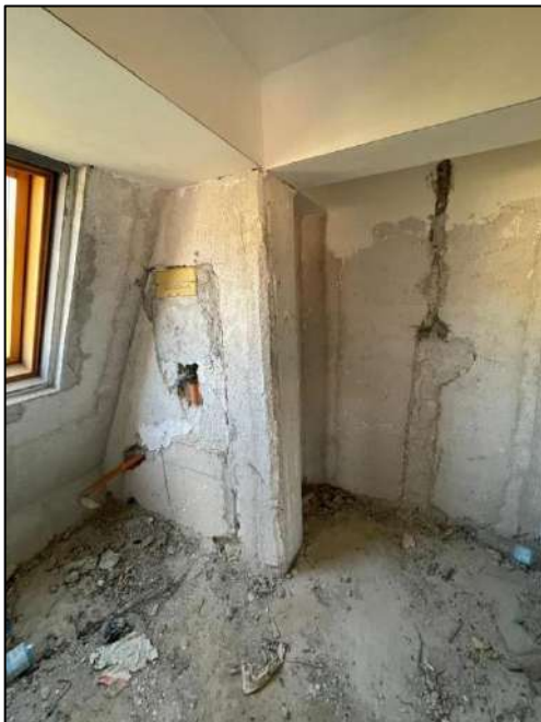
Foto interna dei locali
