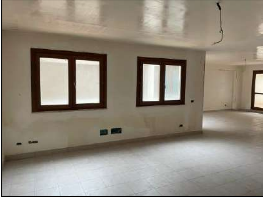
Foto interna dei locali
