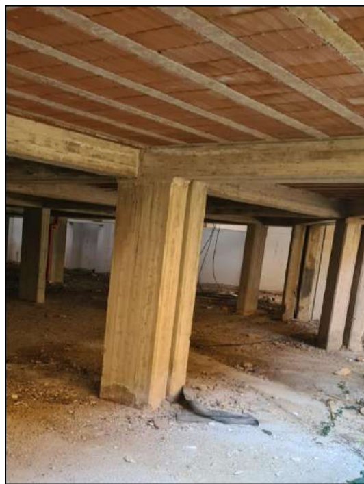
Foto interna dei locali
