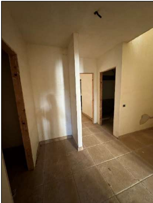
Foto interna dei locali
