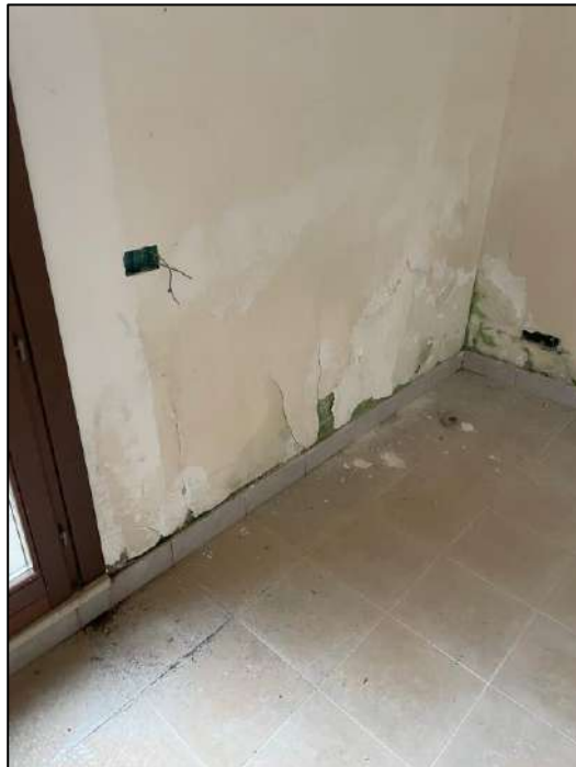
Foto interna dei locali
