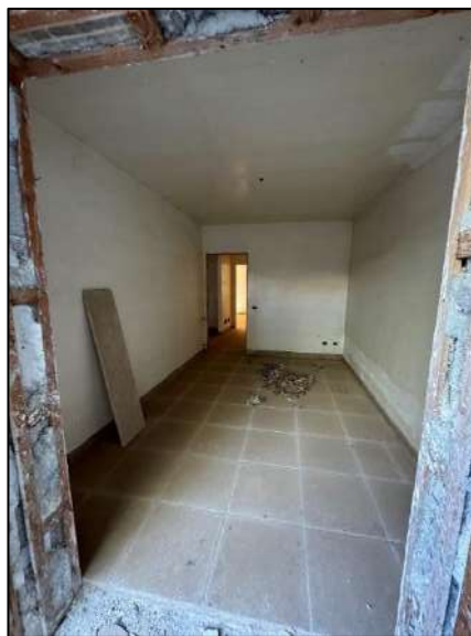
Foto interna dei locali
