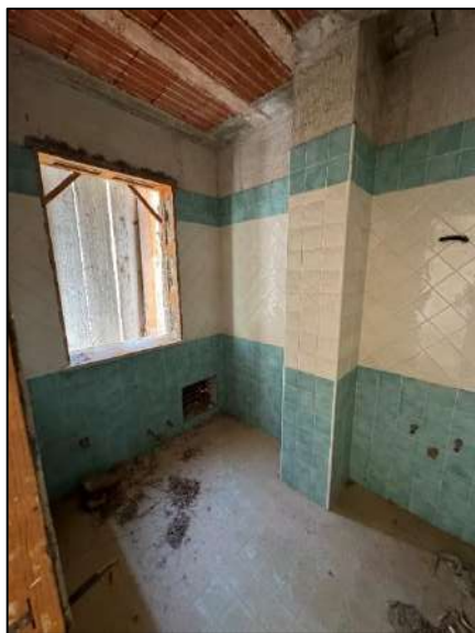
Foto interna dei locali
