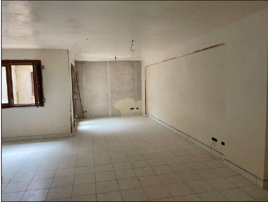
Foto interna dei locali
