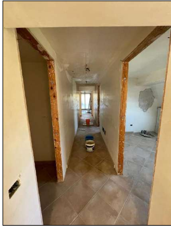
Foto interna dei locali
