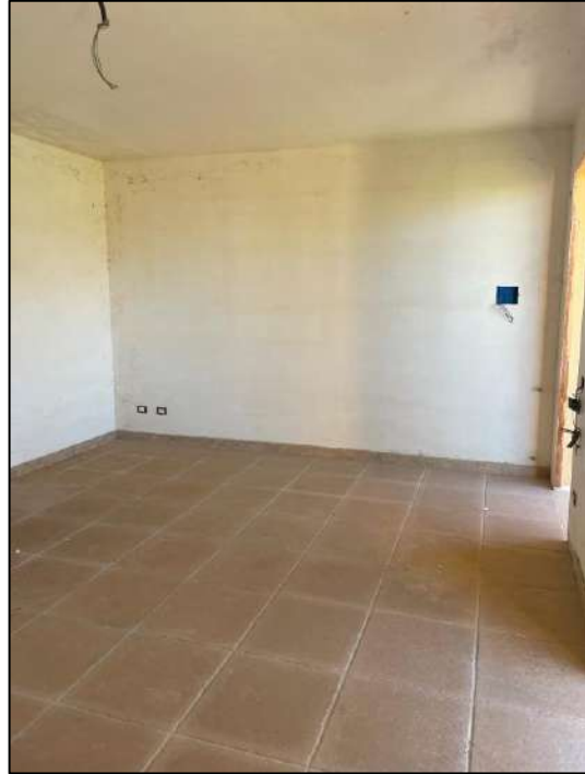
Foto interna dei locali
