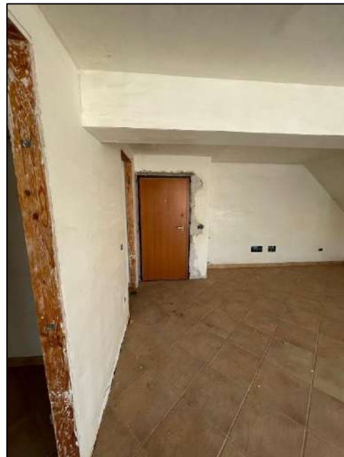
Foto interna dei locali
