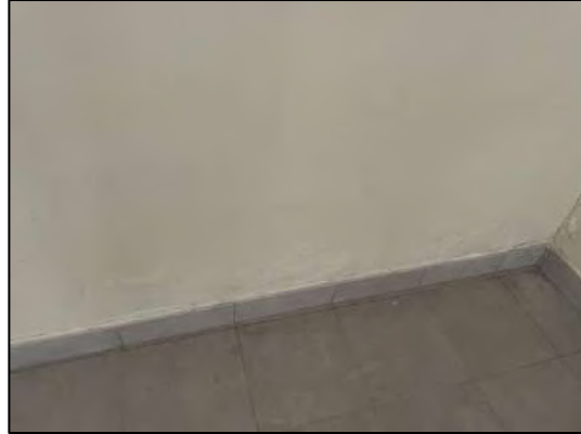
Foto interna dei locali
