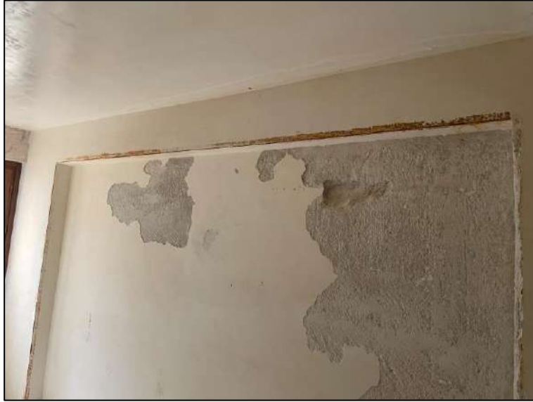
Foto interna dei locali
