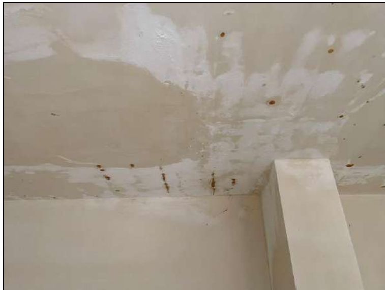
Foto interna dei locali
