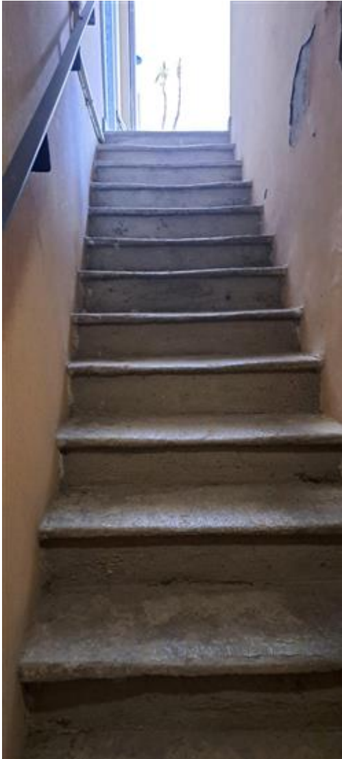
scala di accesso alla cantina
