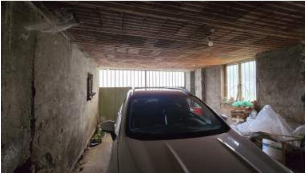
Vista interna deposito sub 18
