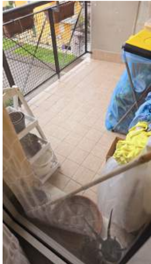
Vista esterna terrazzino
