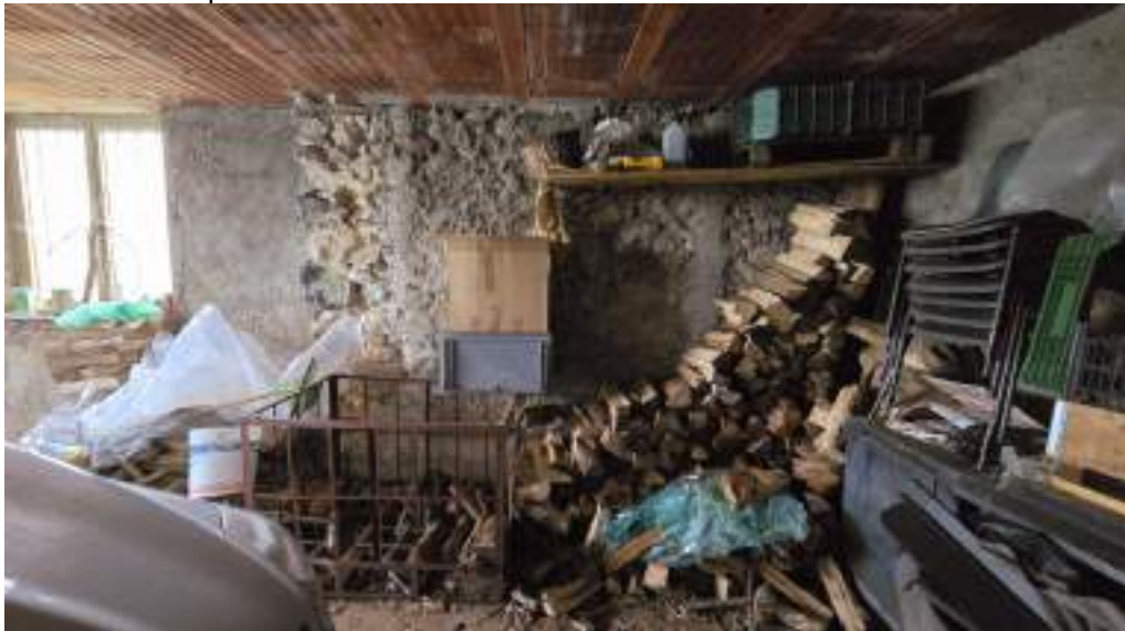
Vista interna deposito sub 18
