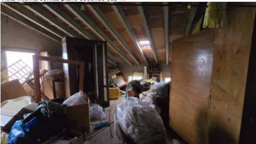
Vista interna soffitta piano secondo sub 17
