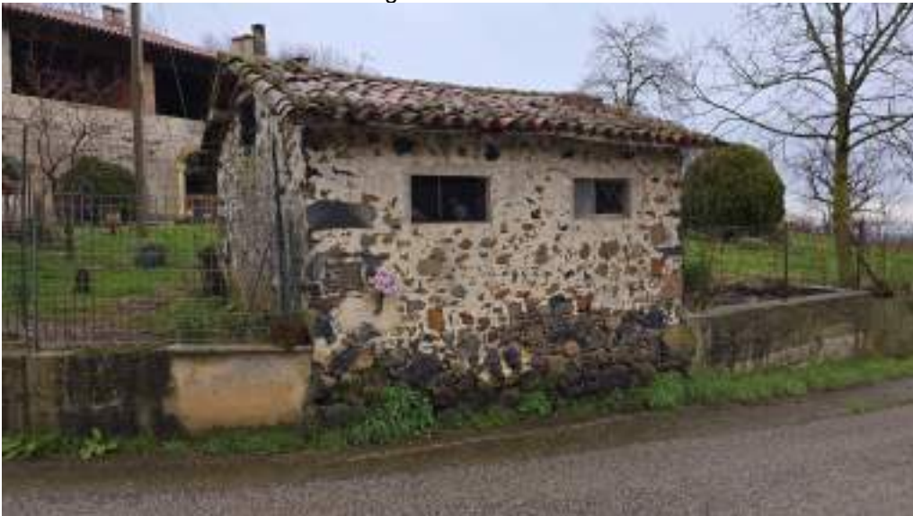
Vista esterna deposito sub 9 lato sud-ovest
