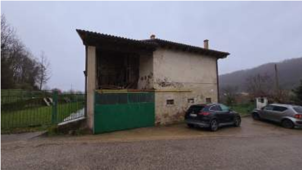
Vista esterna edificio di contrada Grigolati lato ovest
