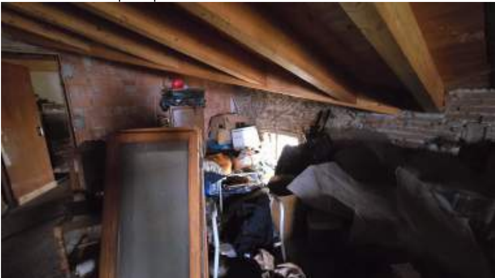
Vista interna soffitta piano secondo sub 17
