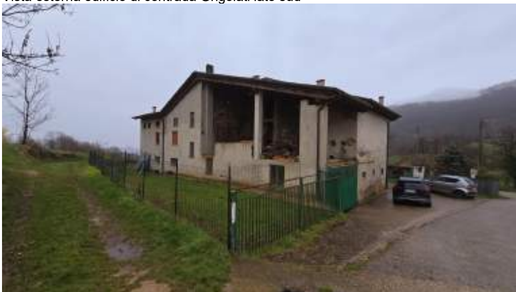
Vista esterna edificio di contrada Grigolati lato nord-ovest
