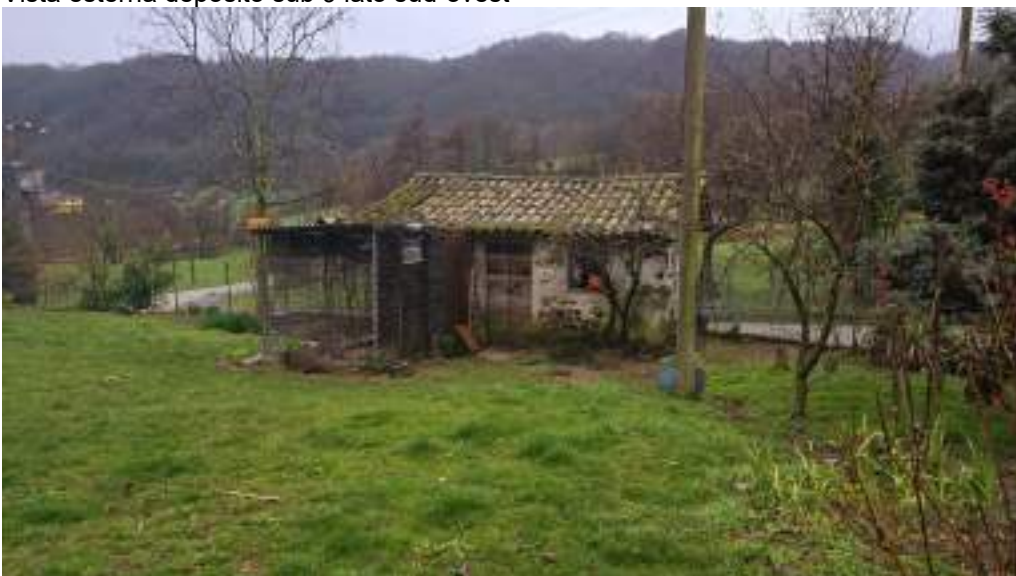
Vista esterna deposito sub 9 lato nord
