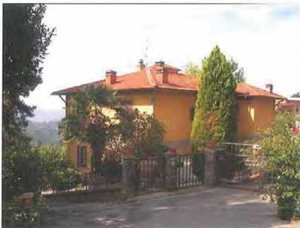
Fotografia 1: Vista del fabbricato che comprende i beni 1, 2, 3 e 4
