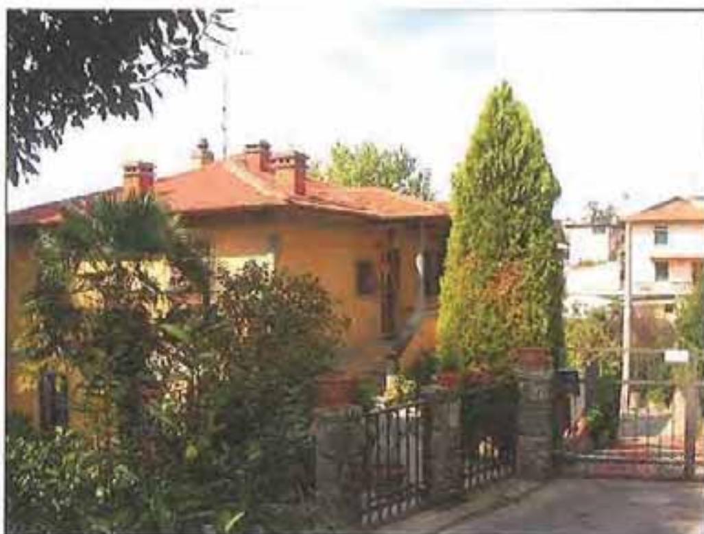
Fotografia 2: Altra vista del fabbricato
