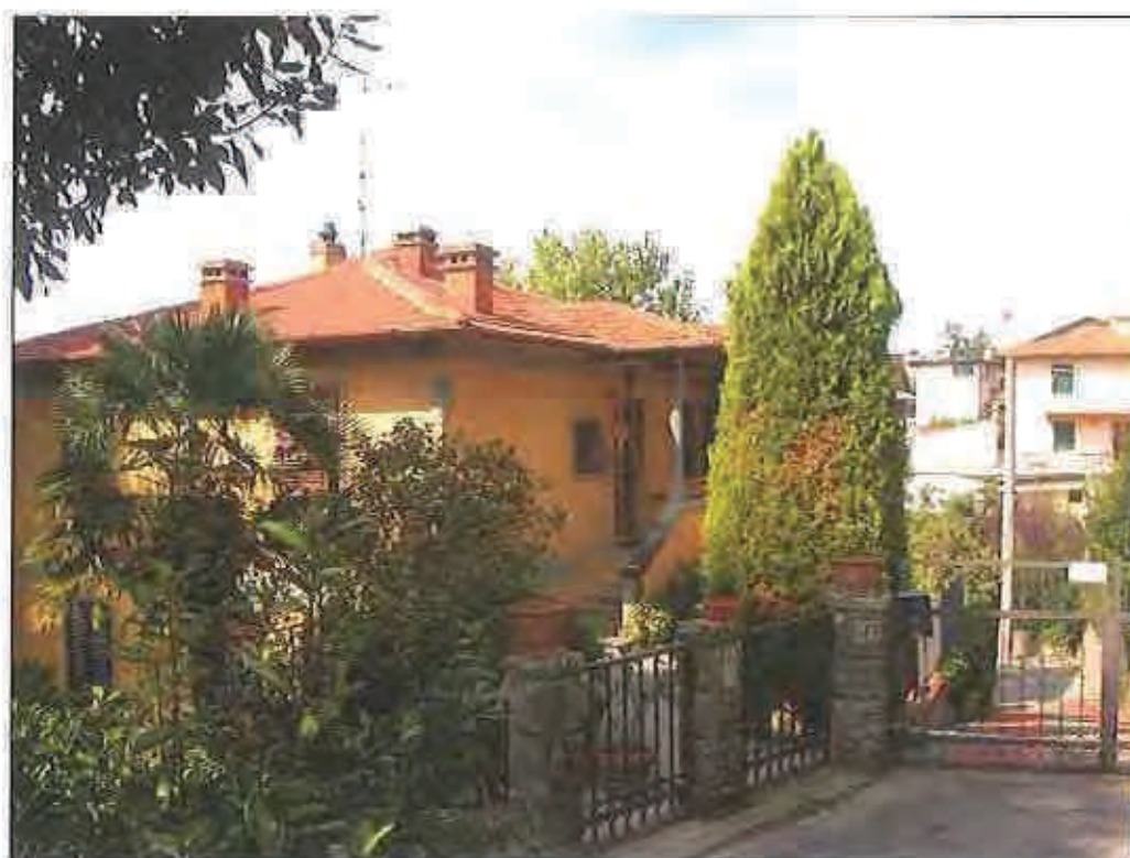
Fotografia 2: Altra vista del fabbricato
