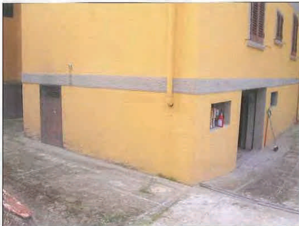
Fotografia 4: Vista dall'esterno della centrale termica
