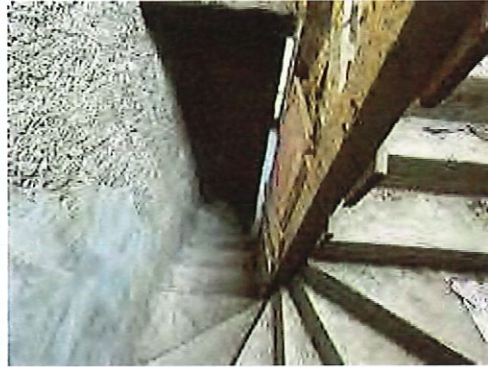
corpo B - rustico: scala dal Piano 1° al Piano 2°
