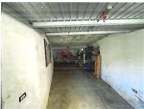
corpo C - box: interno
