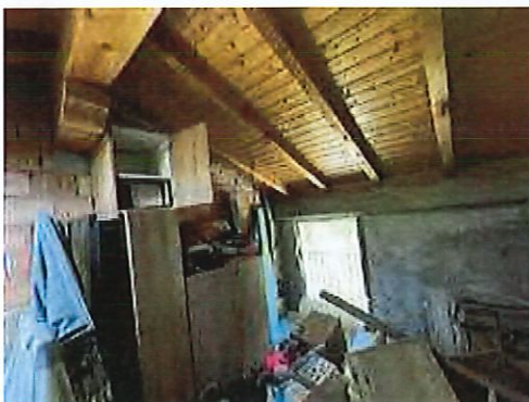
corpo B - rustico: locale al Piano 2° sottotetto
