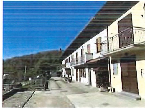
la cascina in linea ristrutturata (facciata sud-est)
