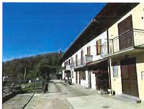
la cascina in linea ristrutturata (facciata sud-est)
