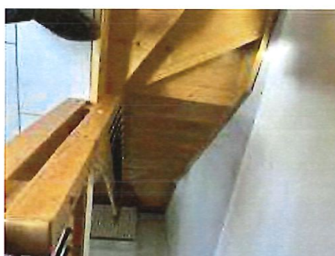
corpo A - appartamento: scala interna
