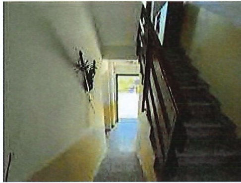
corpo A - appartamento: vano scala
