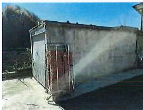
corpo C - box: vista laterale
