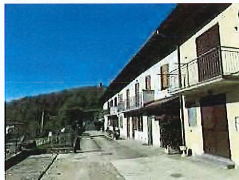
la cascina in linea ristrutturata (facciata sud-est)
