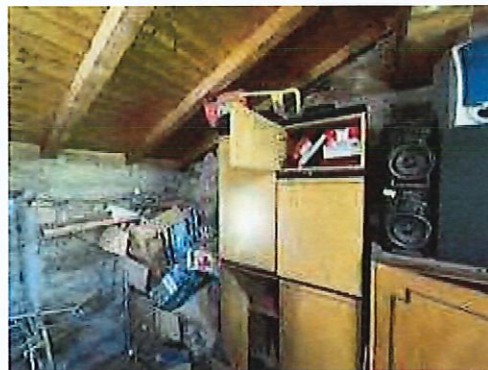
corpo B - rustico: locale al Piano 2° sottotetto
