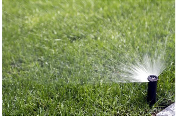
1 Impianto di irrigazione del verde condominiale
