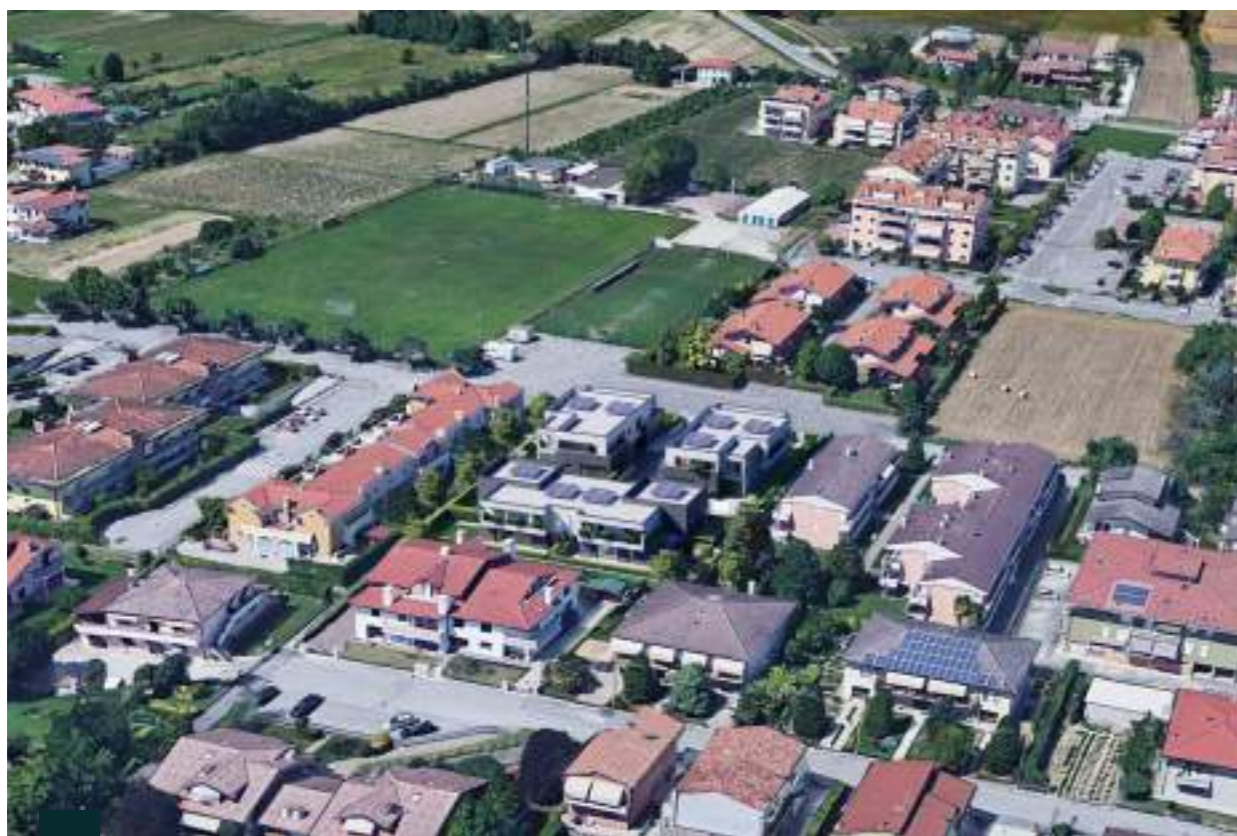
Veduta Sud dell'intervento
