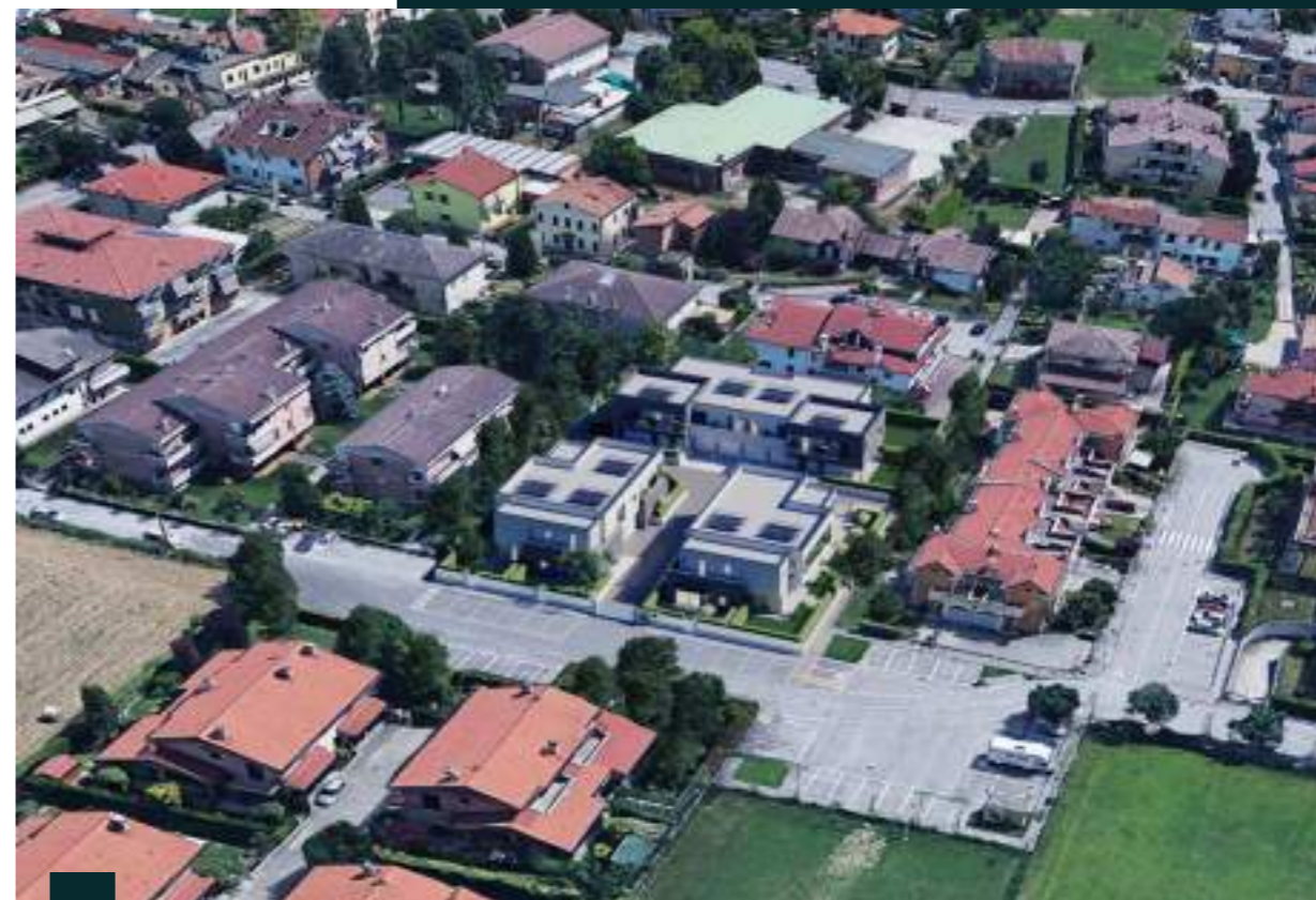
Veduta Nord dell'intervento
