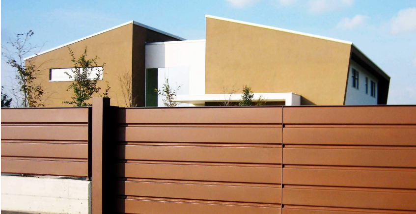
Cancelli in barriera metallica verniciata ral.
