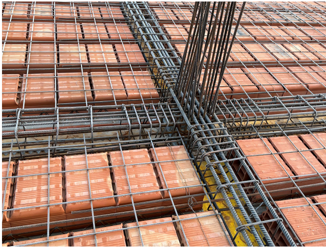
Solaio travetti e pignatte armato
