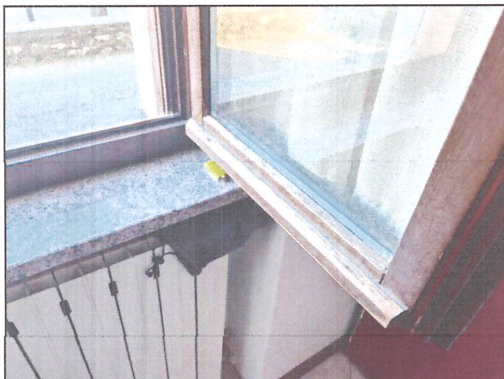
FOTO 22 U.I. MAPP. 304 SUB. 2 VISTA PARTICOLARE RIPRESA VERSO FINESTRA DELLA CAMERA MATRIMONIALE.
