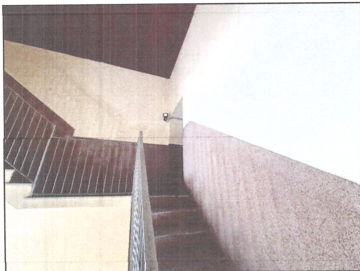
FOTO 30 VISTA VANO SCALA COMUNE DI COLLEGAMENTO CON IL SOTTOTETTO.
