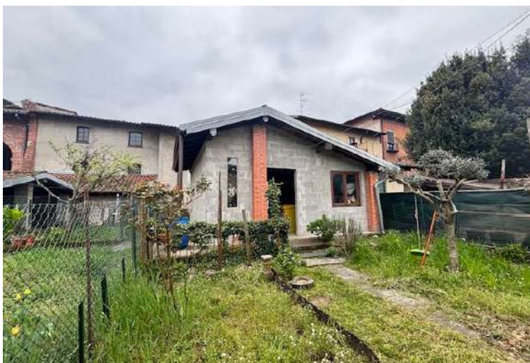
tettoia in corpo esterno
