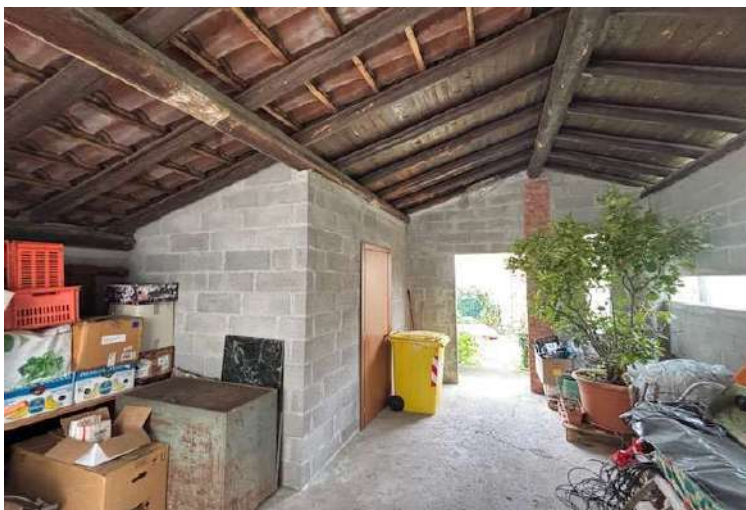
tettoia in corpo esterno - interno
