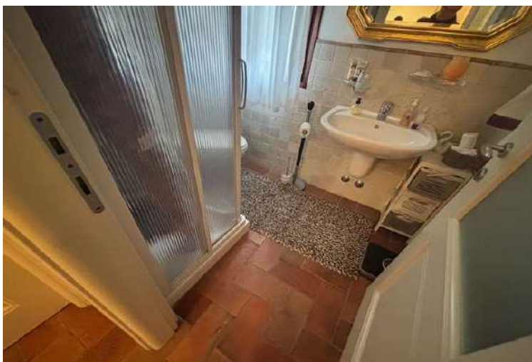
interni piano terra - bagno
