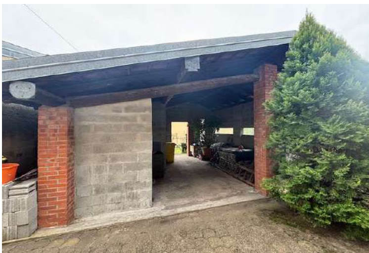
tettoia in corpo esterno
