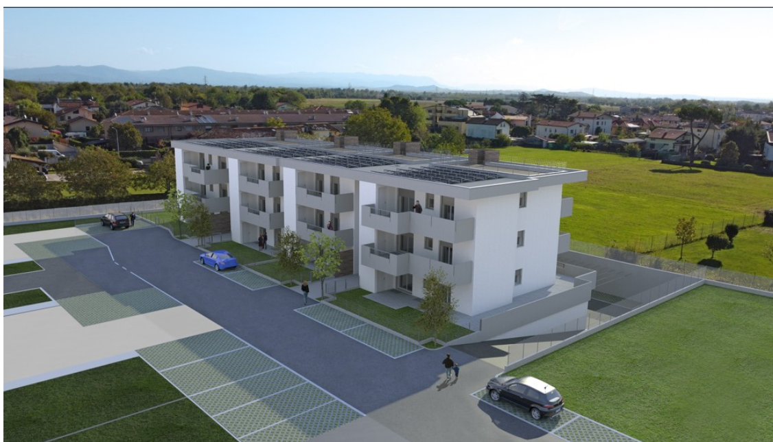
Edificio E e Edificio F: vista dalla strada privata interna
