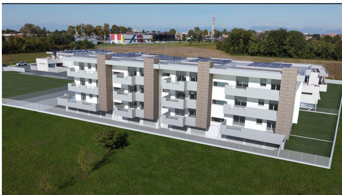
Edificio E e Edificio F: vista dalla zona garages
