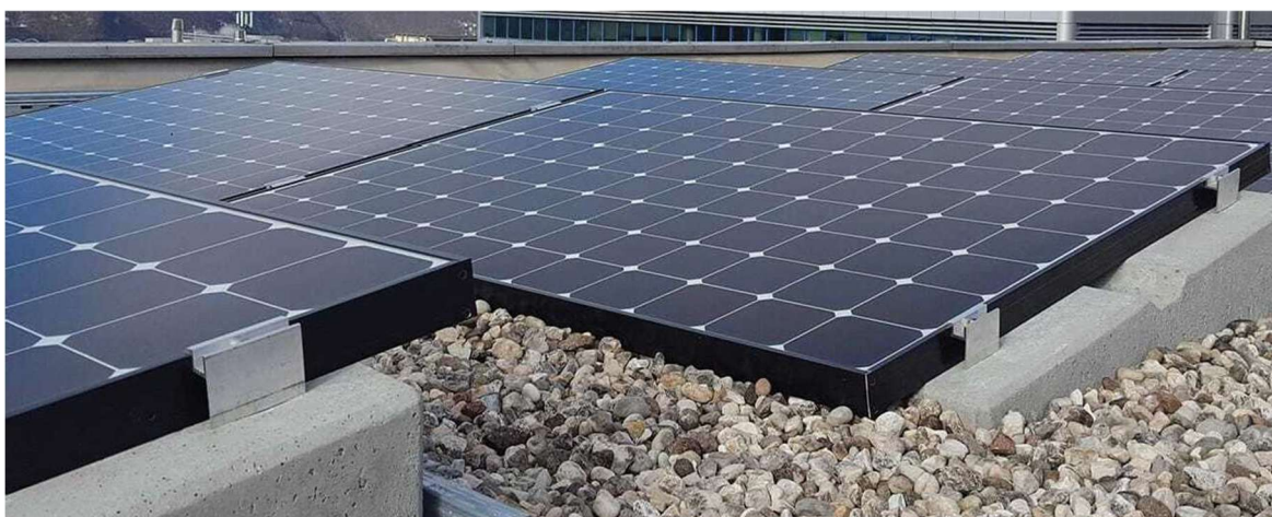
Fotovoltaico su tetto con ghiaia
