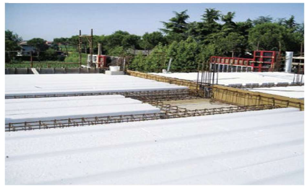
Posizionamento del solaio
