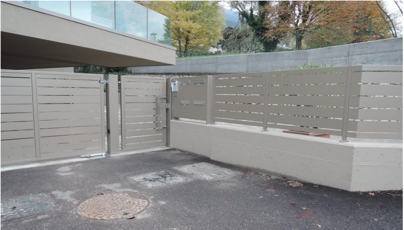
Foto esempio pannellatura semi/ceca
