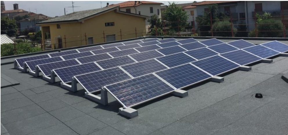
Esempio di pannelli fotovoltaici integrati nella falda.
