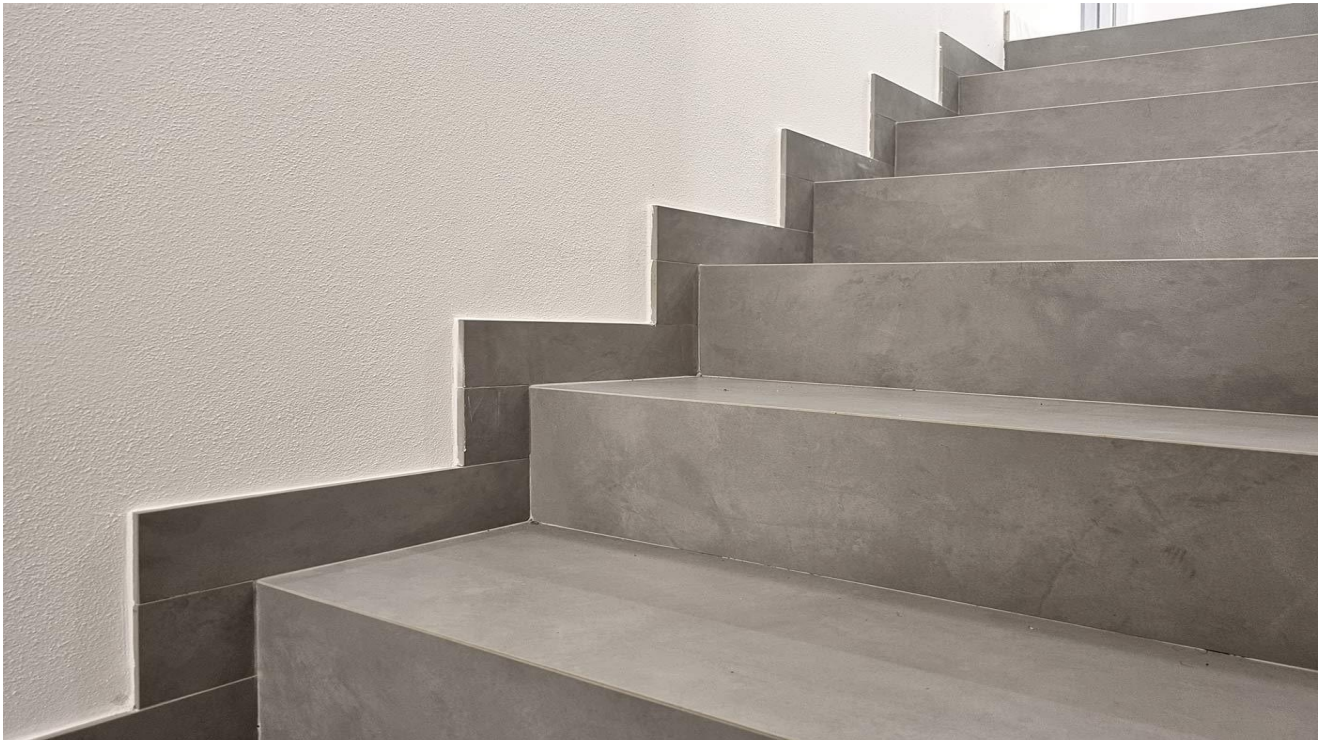
Esempio di scala con finitura in gres porcellanato
