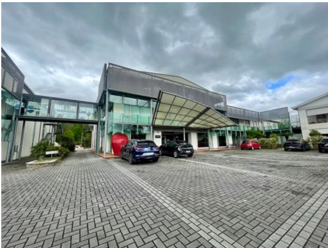
Vista esterna generale – fronte strada (sud)
