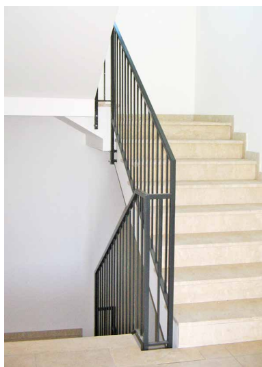
F _ Scala interna
