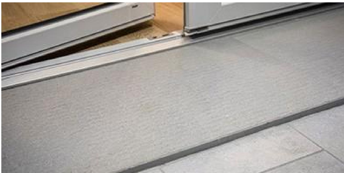
Vialetto di ingresso pedonale rivestito in gres porcellanato antigelivo o cubetti di porfido a scelta D.L
