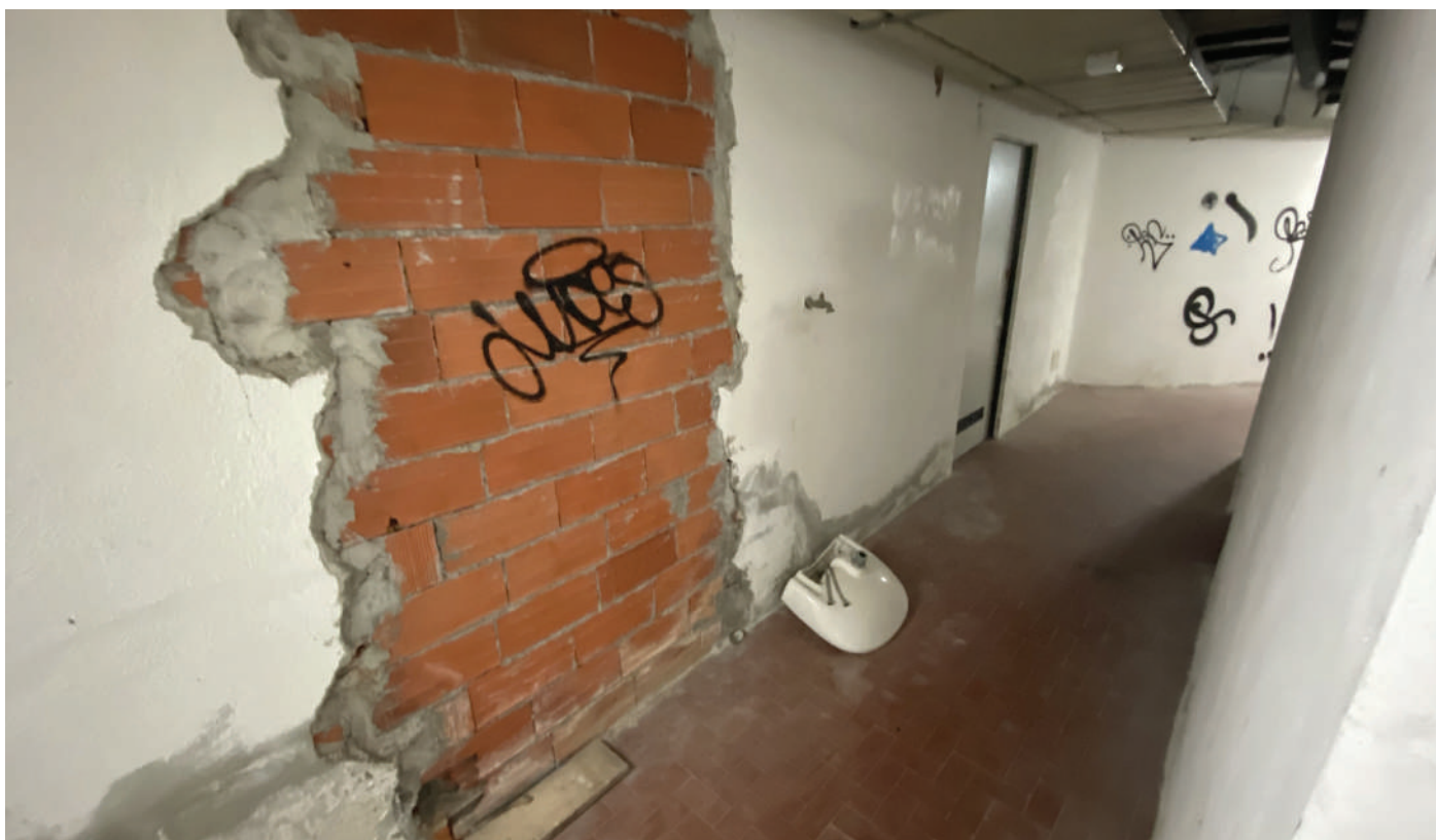
FOTO 6 - Vista interna del corridoio principale del piano interrato e accesso al sub 62 murato;
