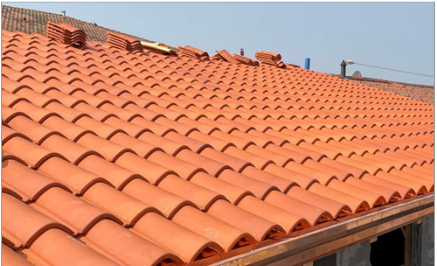
FOTO 3 - TEGOLE E LATTONERIE IN FASE DI POSA
