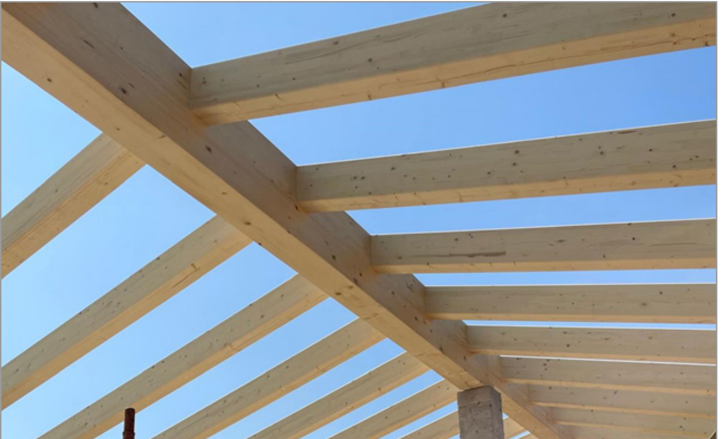
FOTO 2 - STRUTTURA IN LEGNO
