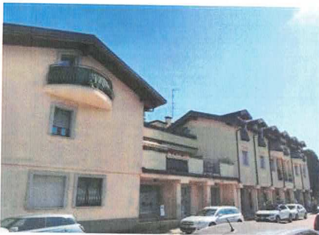
VISTA ESTERNA - PARTICOLARE
