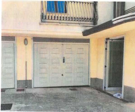
VISTA BOX E CORSELLO
