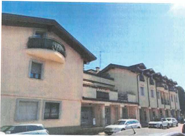
VISTA ESTERNA -PARTICOLARE
