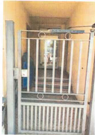
CANCELLO INGRESSO PEDONALE
