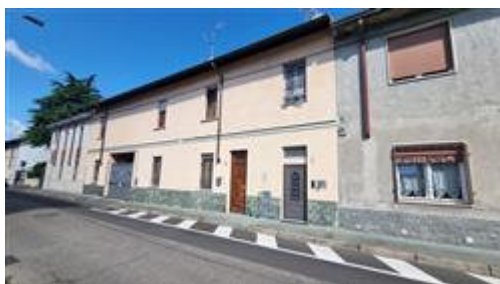
prospetto principale su Via G. Da Legnano
