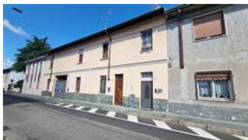
prospetto principale su Via G. Da Legnano
