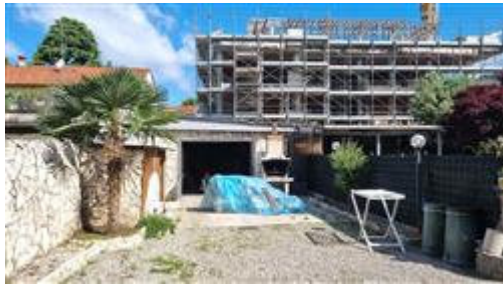
prospetto box con parte del cortile di proprietà
