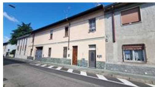
prospetto principale su Via G. Da Legnano
