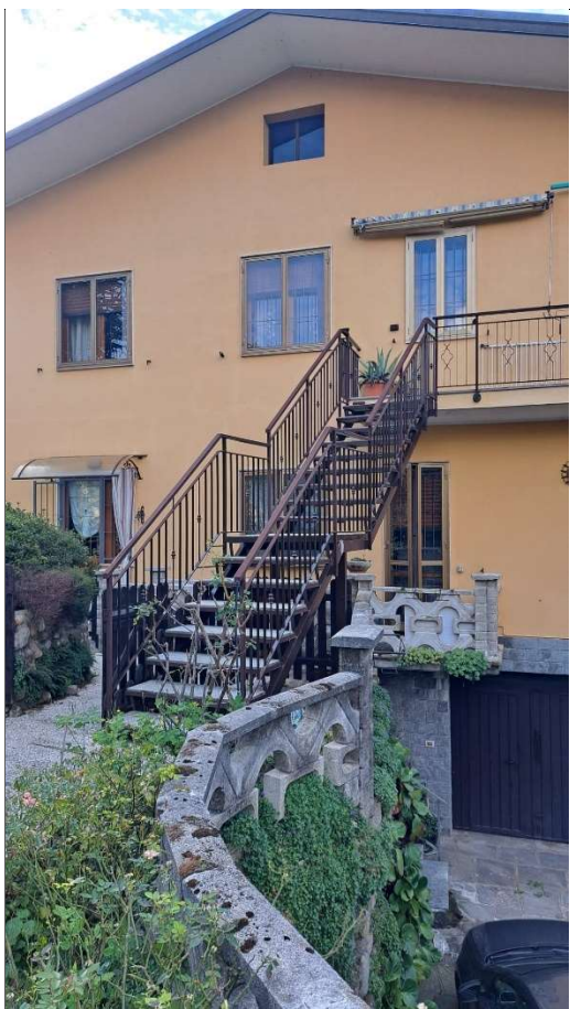
Foto 1 - Vista su lato est
