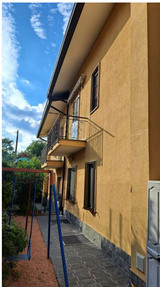
Foto 2 - Vista su lato sud
