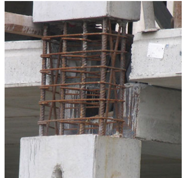
Esempio di prolungamento dei pilastri
