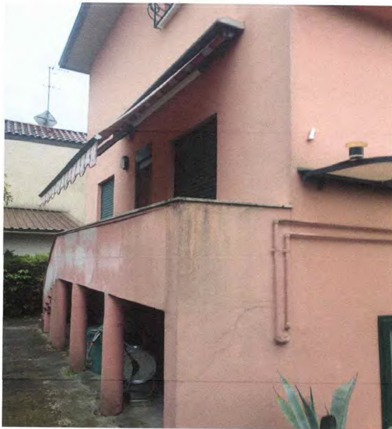
scorcio lato est dalla corte interna
