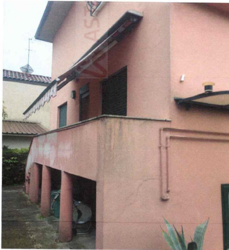
scorcio lato est dalla corte interna
