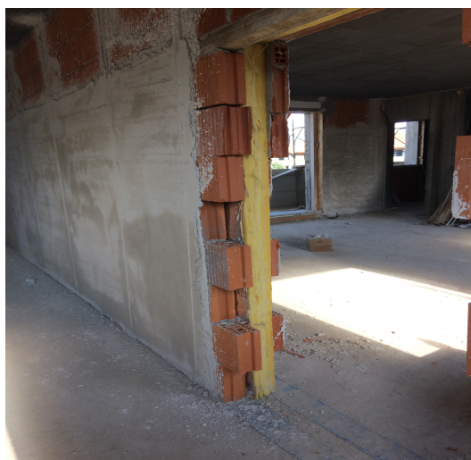
Parete divisoria tra appartamenti
