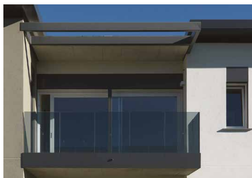
B1 - g _ Balconi con parapetti in vetro
