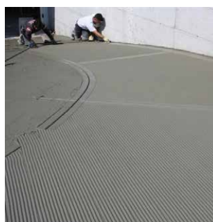
D1 - d _ Rampa corsello
