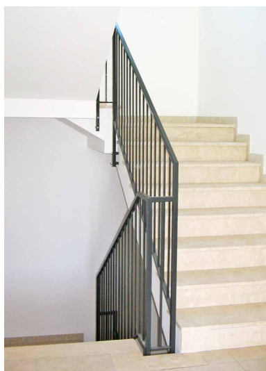
F _ Scala interna
