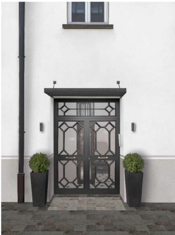
Portone d'ingresso edificio dal cortile
